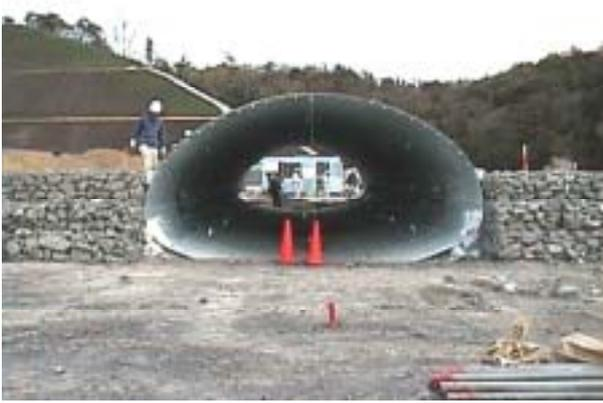
図1 コルゲートカルバートの施工状況
