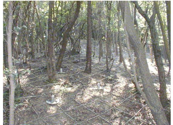
図-1 ロックボルト・ロープネット併用工法
