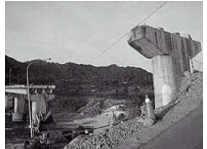
写真-1 隆起による碑豊橋の落橋
