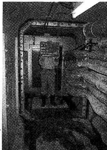
写真-2 開削式とう道の伸縮継手部の復旧状況
