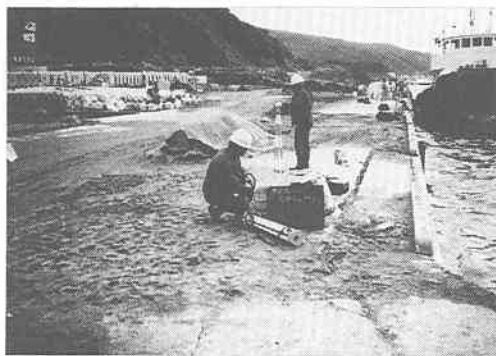
写真 10.2.7 奥尻港岸壁(-6.5 m)の被災状況
