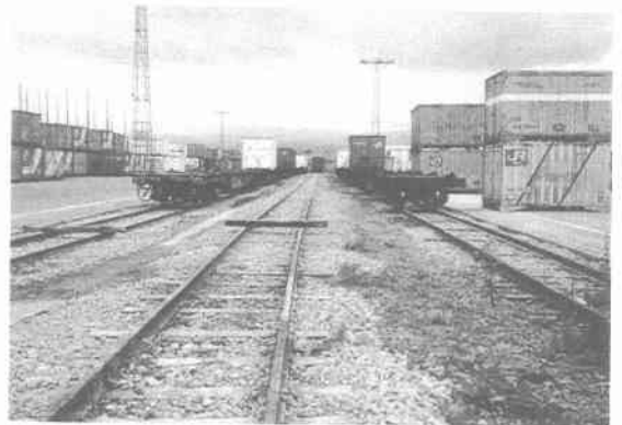
写真 8.3.2 旧有川棧橋(バラスト上の噴砂発生跡)
