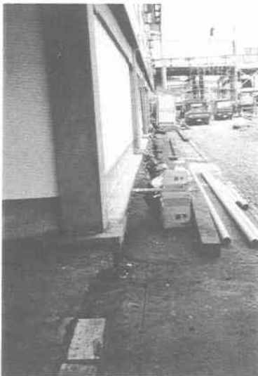
写真 8.3.3 シーポートプラザ(岸壁と背後の地盤の間が開く)
