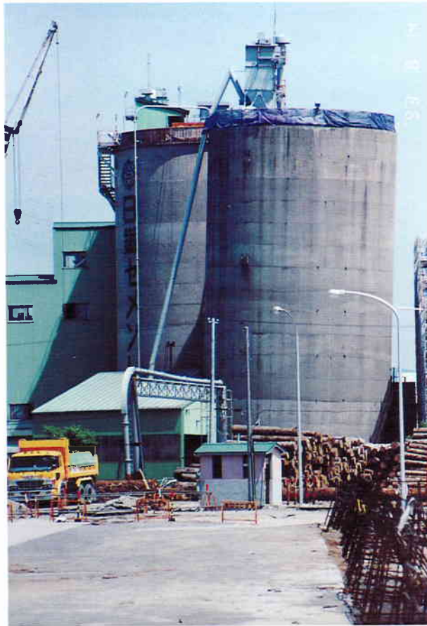
口絵写真-7 液状化によるサイロの傾斜（函館港）
