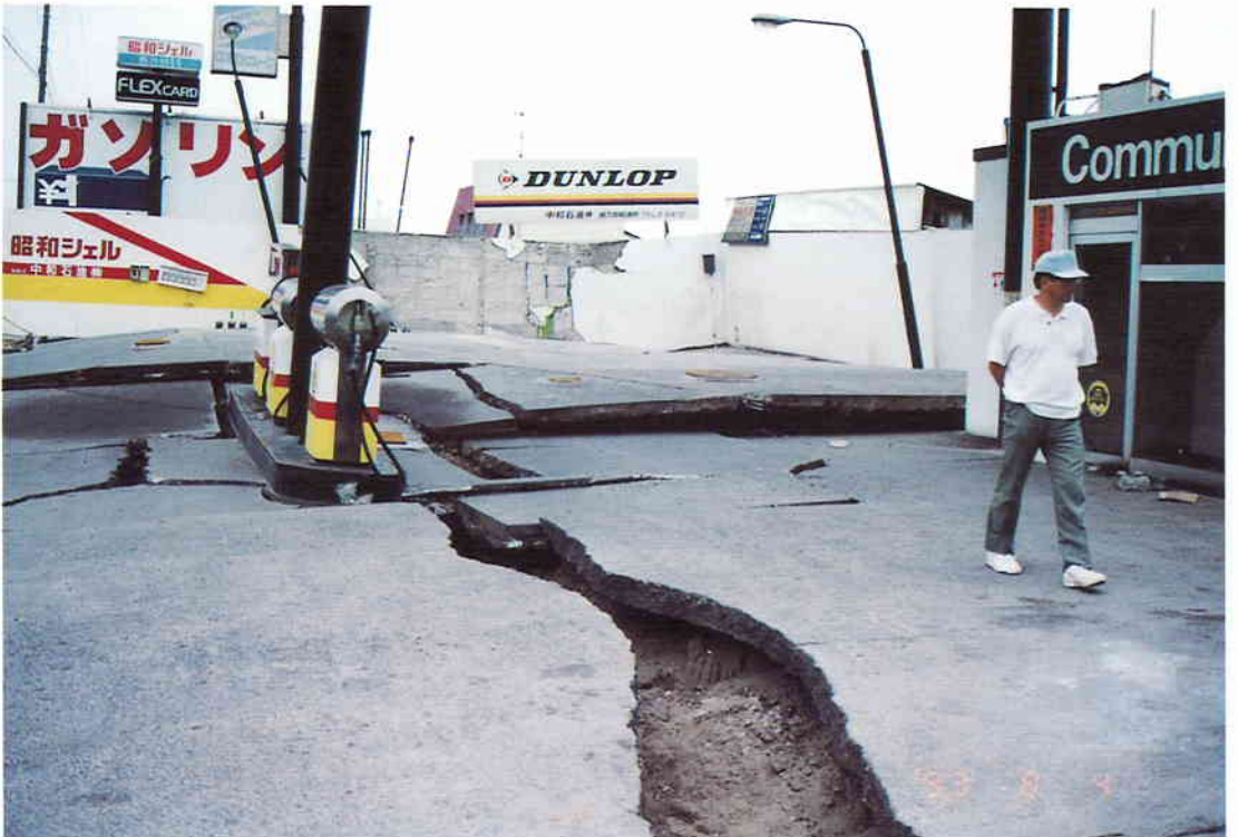
口絵写真-6 液状化による地下タンクの被害（長万部市内）
