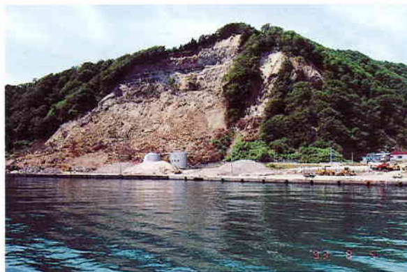
口絵写真-2 奥尻町奥尻の崖崩れ（ホテル洋々荘を含み数棟の建物が土砂に埋没し，24名の死亡が確認された）
