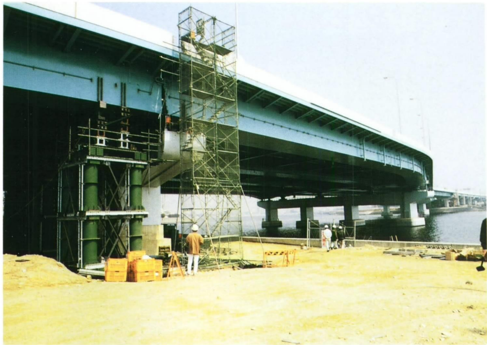
写真－２．４ 岸壁に近い橋脚の移動
