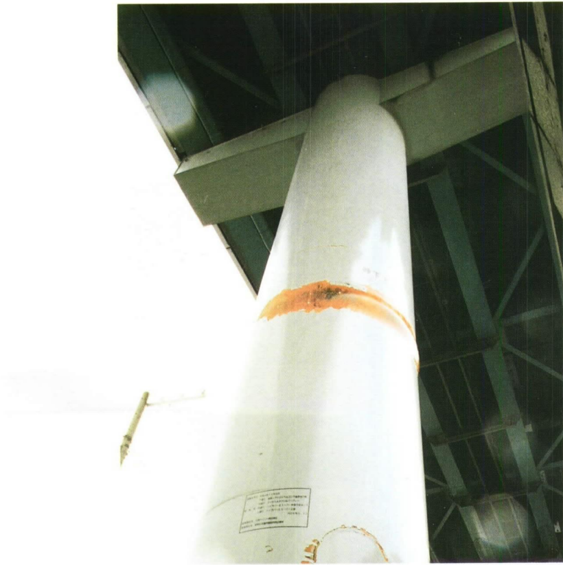
写真－２．７ 円形断面の橋脚中間部の局部座屈
