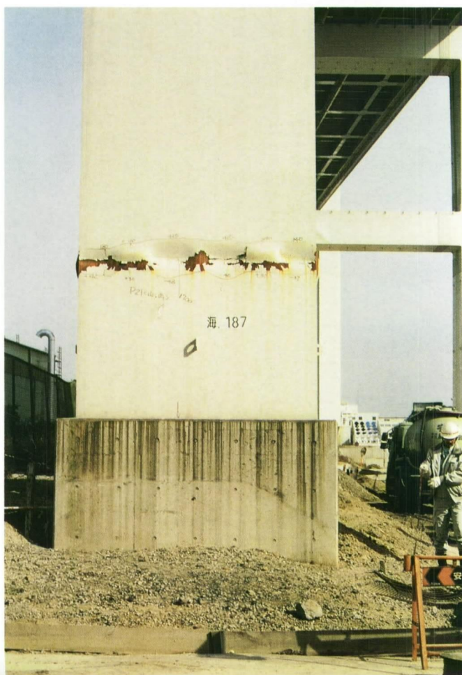
写真－２．４ 岸壁に近い橋脚の移動
