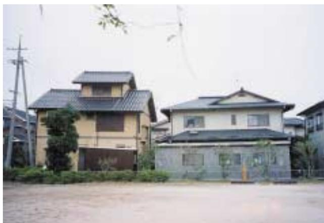
写真-1 鳥取県西部地震の際に液状化によって傾いた家屋
