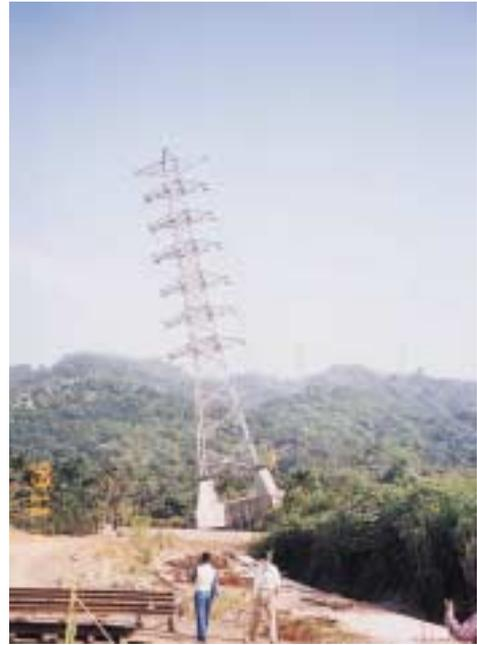
写真-3 台湾・集集地震で発生した断層上にあつた送電鉄塔（鉄塔下の右半分の地盤が持ち上がったが鉄塔は基礎が強くて傾いただけで崩壊しなかった）
