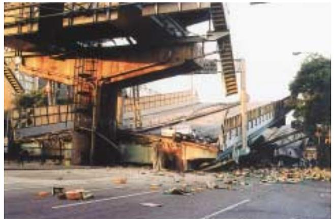
写真-1 兵庫県南部地震で倒壊した阪神高速道路
