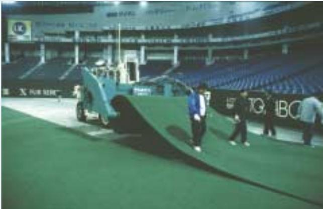
写真-2 人工芝は4m幅で巻き取る
