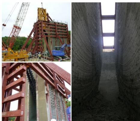
写真1 SATT工法の拡翼式ツインカッターによる試験施工の様子
