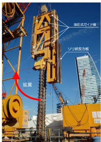
写真2 SATT工法の掘削機と姿勢制御機構
