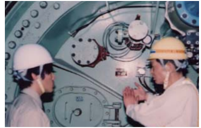
写真-5 現在掘られている日比谷共同溝の先端
