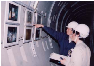
写真-4 麻布共同溝内
