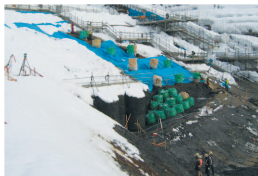
雪と格闘しながら奮闘する技術者たち (洪水吐き付近)
