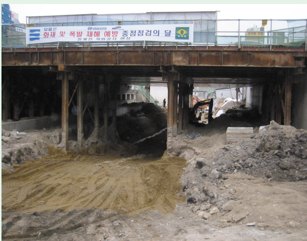
広報館前の現場の施工状況
