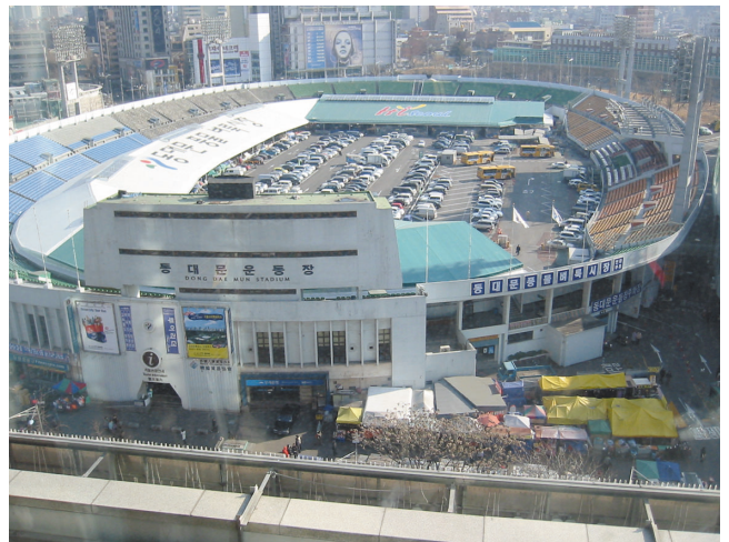
写真-4 交通対策のひとつとして、工事現場近隣の東大門運動場を駐車場として利用
