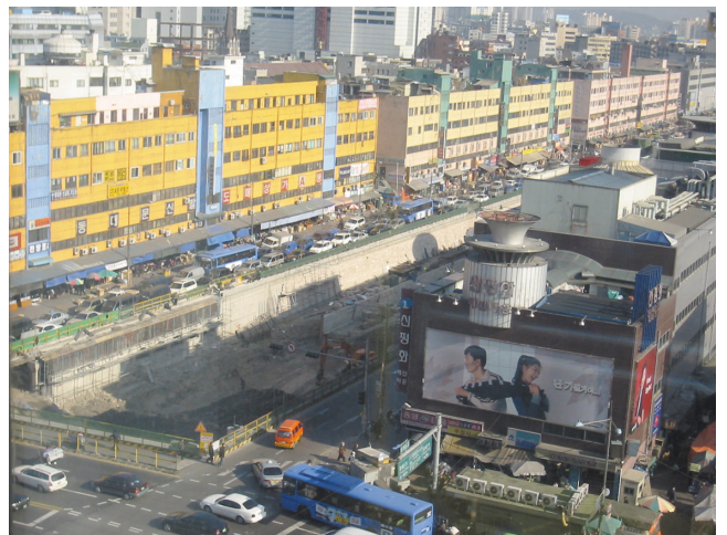
写真-1 近隣ビルより見下ろした清溪川工事風景
