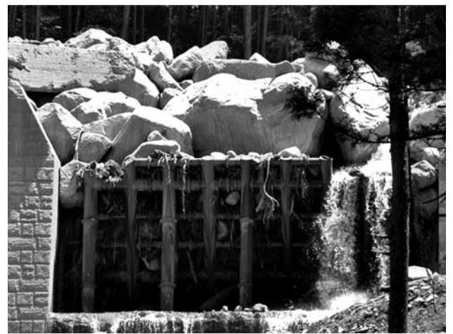
写真3 土石流の先頭部に巨礫が集まる様子
