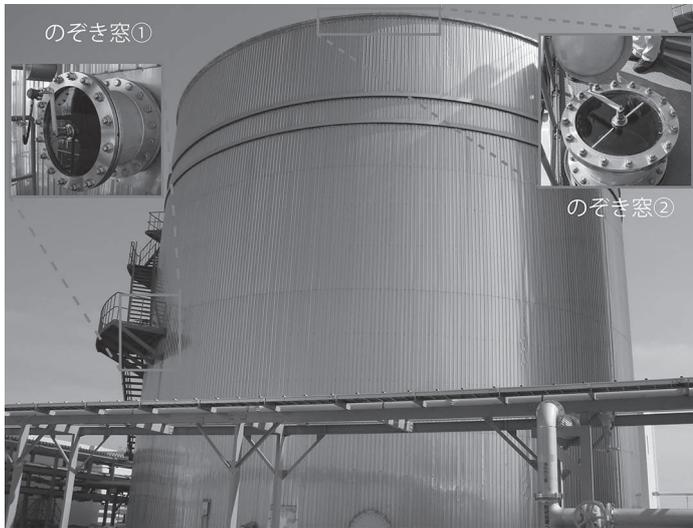
写真1 消化タンクとのぞき窓 (①: タンク中腹、②: タンク上部)
