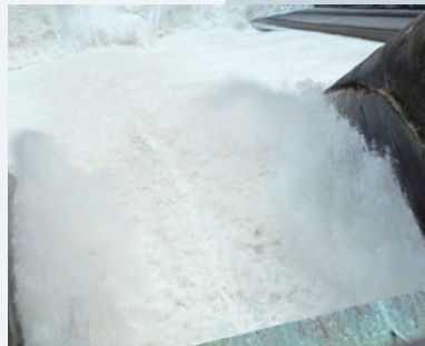
写真1 洪水吐ゲートの真上から見たダム放水
