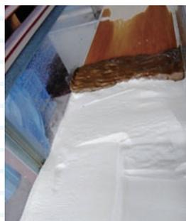
写真2 水路床と砂地盤の境界を粘土で固める
