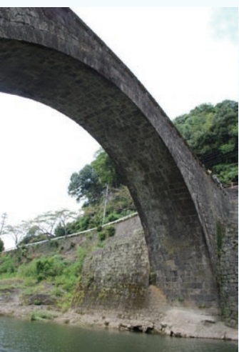
写真1 下から見上げた霊台橋
