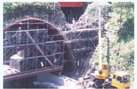
写真3 聖橋の修復工事(熊本県山都町)(提供: (株)尾上建設、尾上氏)
