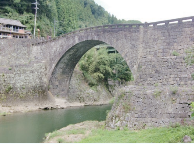
写真2 霊台橋(熊本県美里町)
