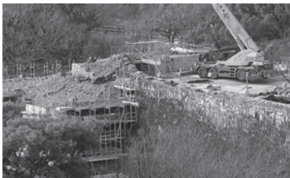
写真2 熊本城の工事の様子
