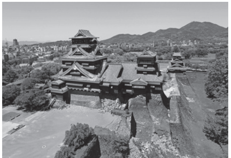
写真1 被災した熊本城天守閣（熊本城復旧基本計画 第1章2ページより）
