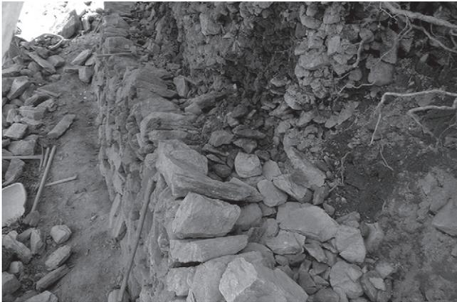
写真3 4日間で、一定区間の石積みを修復する。写真は一度崩した区間の石積みを積みなおしている途中の様子。前面の積み石の裏には「ぐり石」という小さな石を入れる
