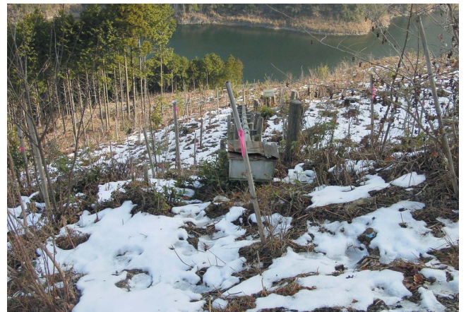
地すべり対策斜面地帯
