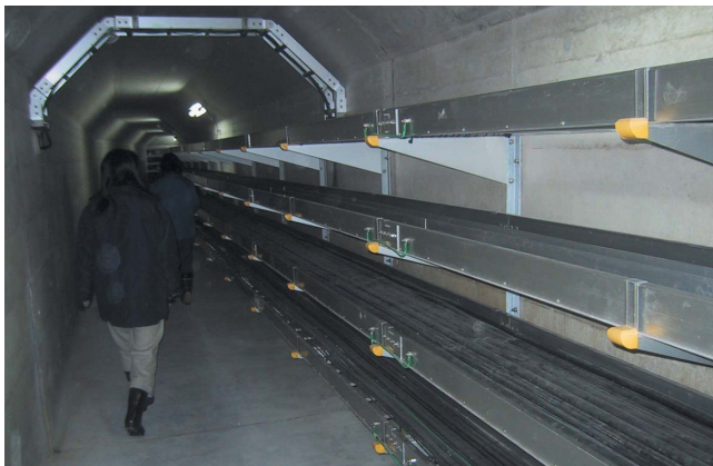
実際の堤体内の通路を移動中
