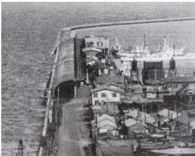
北防波堤ドームの全景（1965（昭和40）年頃撮影）ドーム前面には消波ブロックもなく直接波を受けていたことがわかる。
