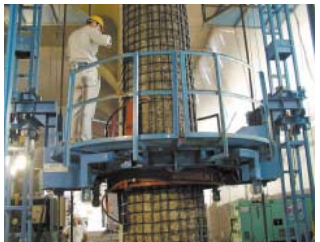
柱の耐震補強工事に用いたPC鋼線自動巻付け機
