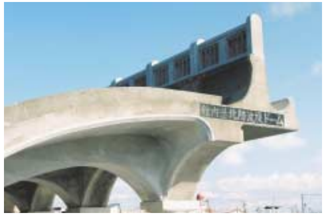
北防波堤ドームの頂上部。上部にある手すり構造のものは設計図上「高欄部」であるが、人が登ることは禁止されている。
