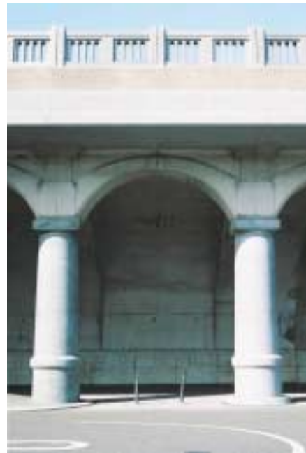
アーチ状の柱と柱の間の桁
