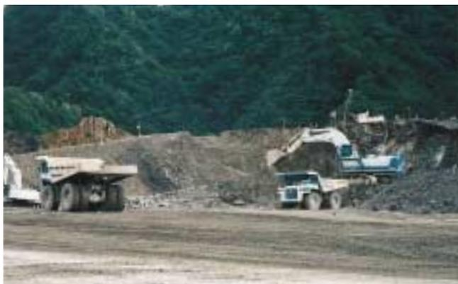
原石山でのロック材の採取。写真中のダンプトラックは90 t 級。奥にある 11 m<sup>3</sup> 級バックホウがとても大きいことがわかる。
