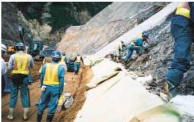
ダムサイト現場での着岩面処理の様子。大きなダムの工事であっても、ここは人の手によって工事がなされている。やはり、機械化が進む中であっても人の手で行う作業の重要性は変わらない。
