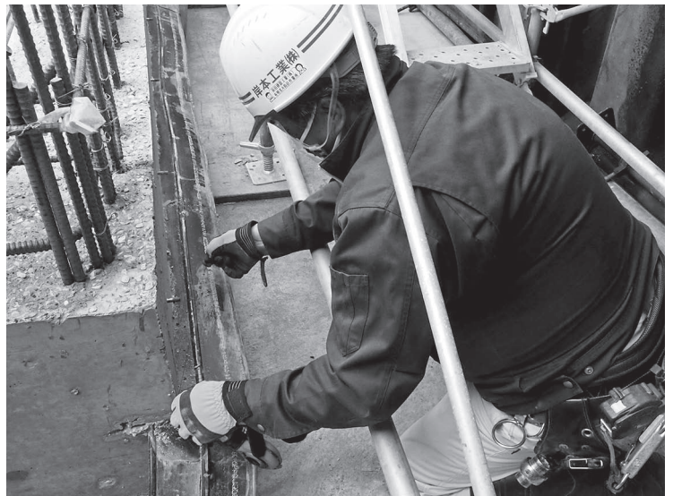
写真1 現場において1mm単位で台の高さの調整を行う阿部氏
