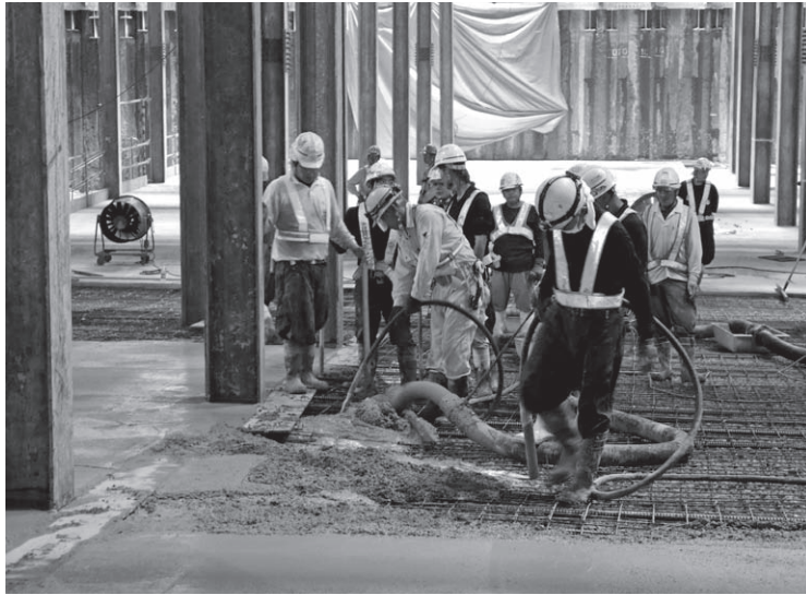
写真1 沼畑氏が職長を務める、とび・土工のグループ（均しコンクリートを打つ様子）
