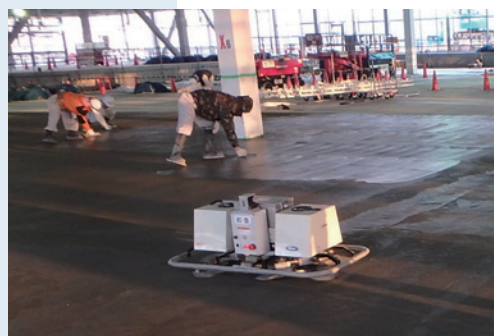
写真3 半自律制御操作可能なコンクリート床仕上げロボット（提供：大成建設（株））
