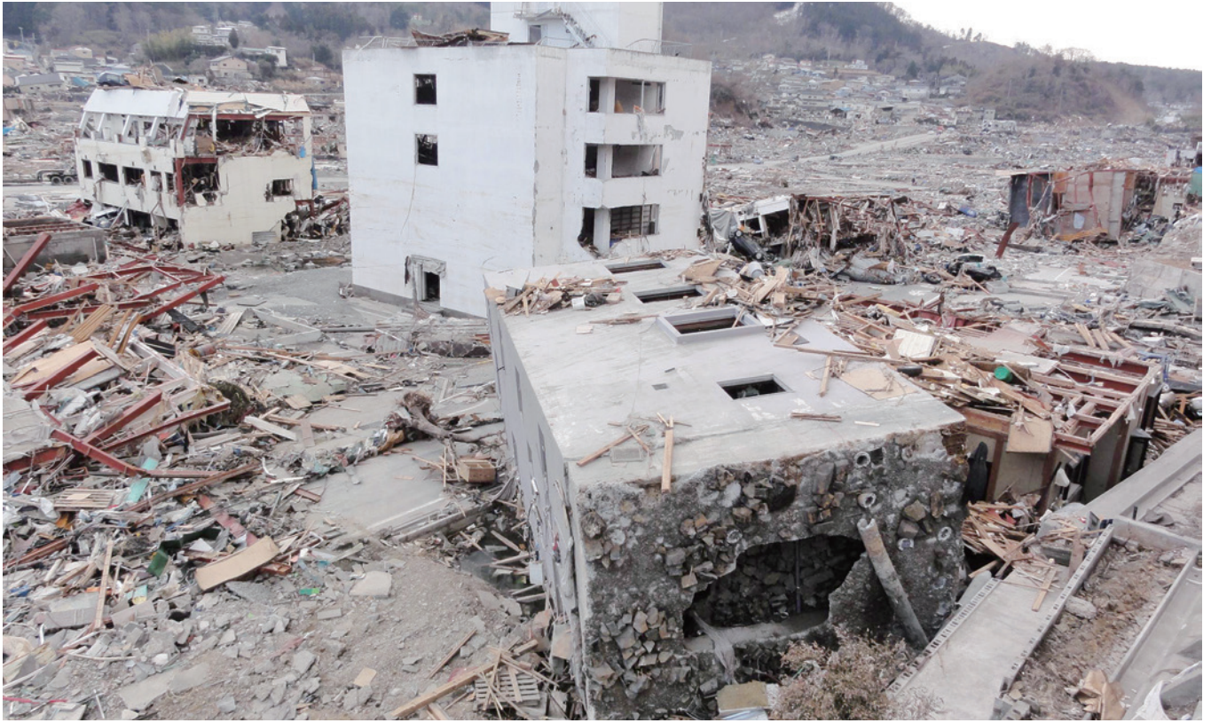
写真1 2011（平成23）年の東日本大震災で転倒した、女川町内の鉄筋コンクリートビル（撮影：東北大学災害科学国際研究所 越村俊一 教授）
