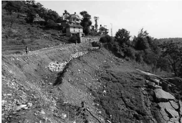
写真3 チャルナケル地区で発生した地すべり:写真右側に崩落した道路が見える
