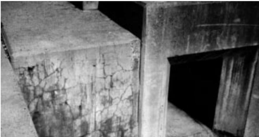
写真 アルカリ骨材反応が生じた構造物の状況例
