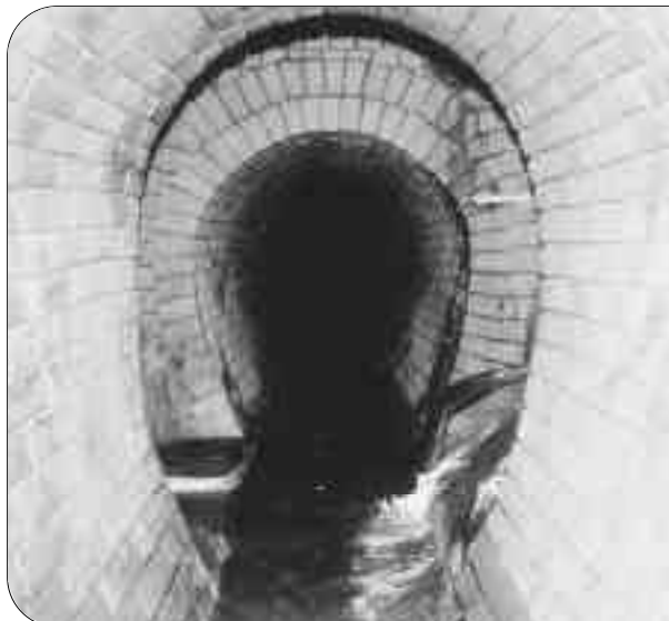
写真-1 神田下水現況(レンガ造り卵形渠)
