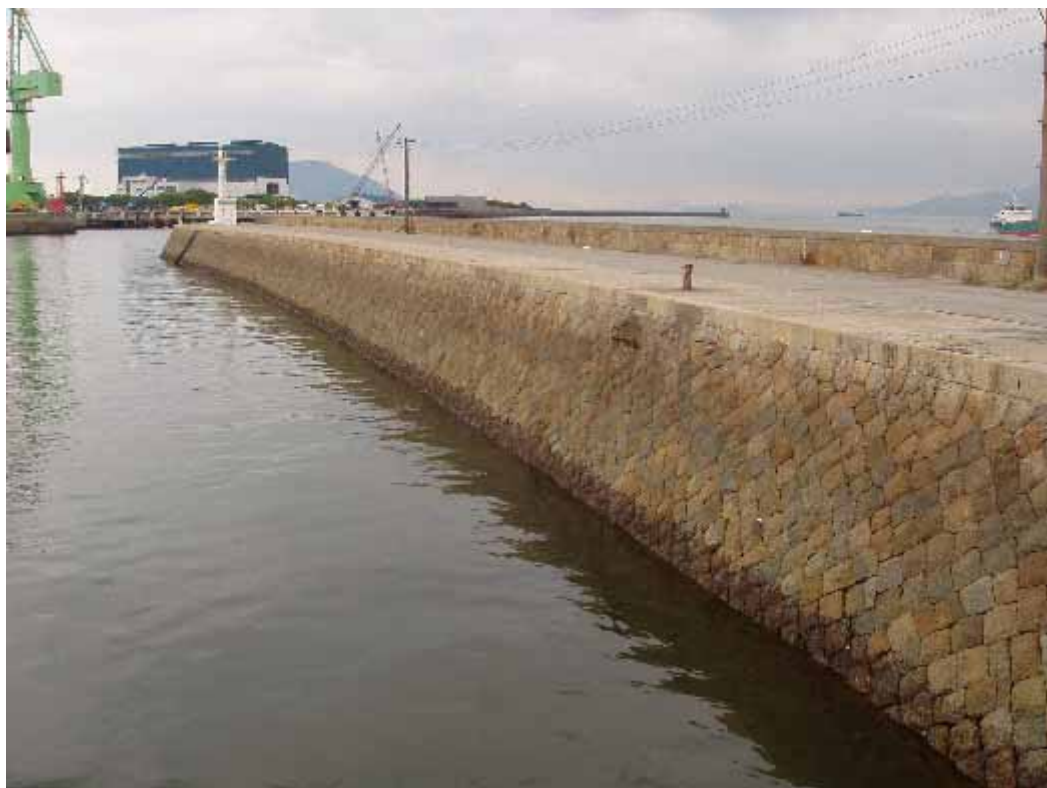
多度津港旧外港東防波堤
