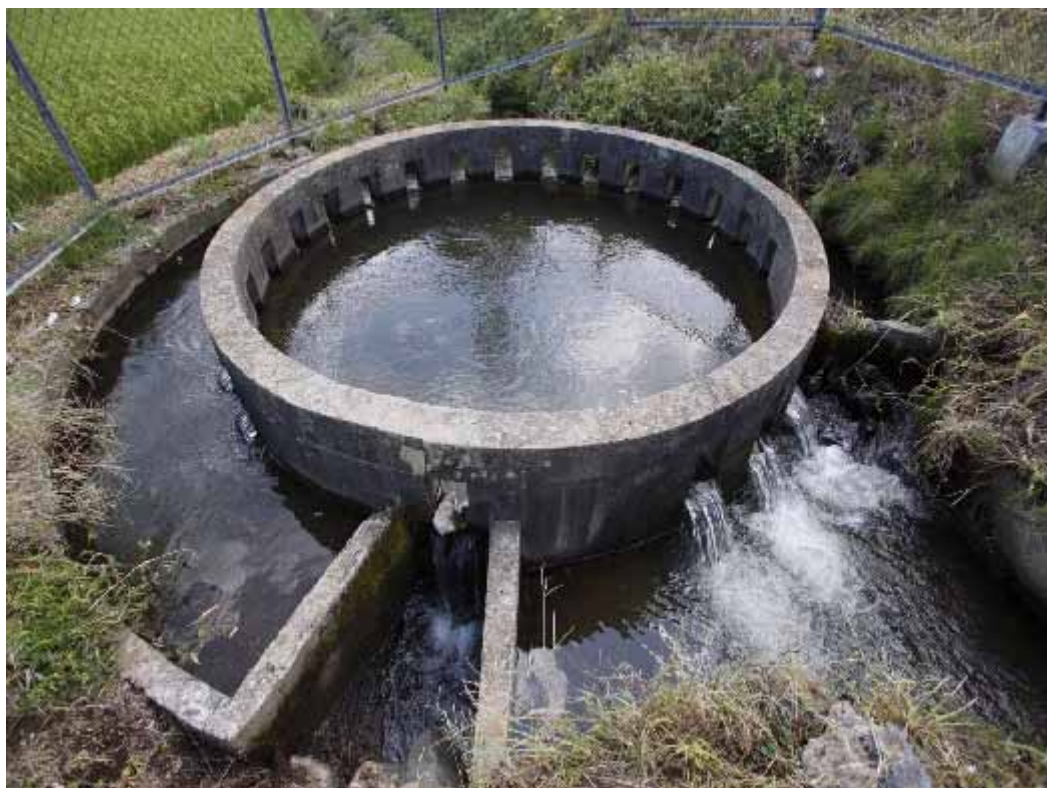
西天竜幹線水路円筒分土工群
