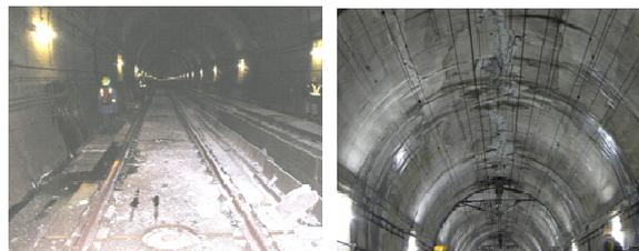
写真 3-2 妙見トンネル被害状況
