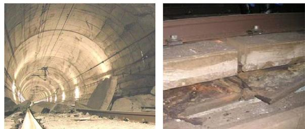
写真-1 魚沼トンネル被害状況
