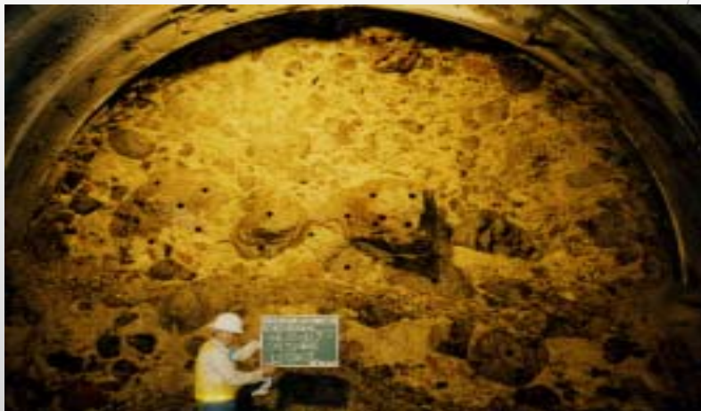
(直径1mを越える巨礫が多く見られる切羽)
