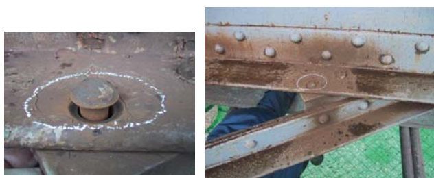
写真 弛緩リベットの例 (シンポジウムの発表スライドより)
