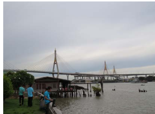
写真-11 リングロード橋
