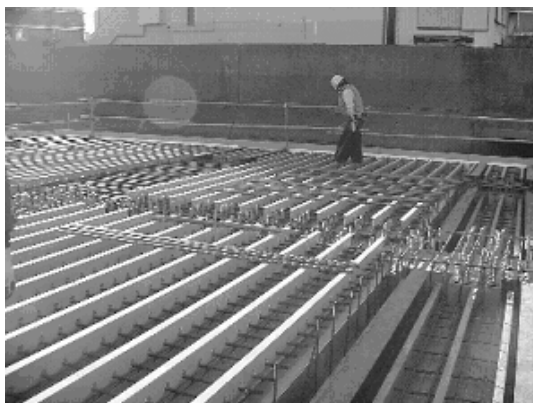
写真 4.4 横桁・床版パネルの設置状況
