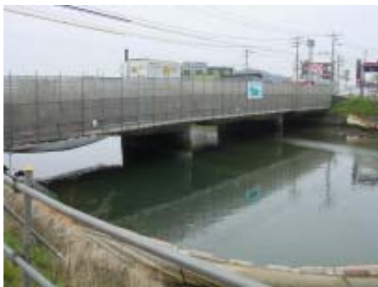
写真 1.1 片平橋の全景
