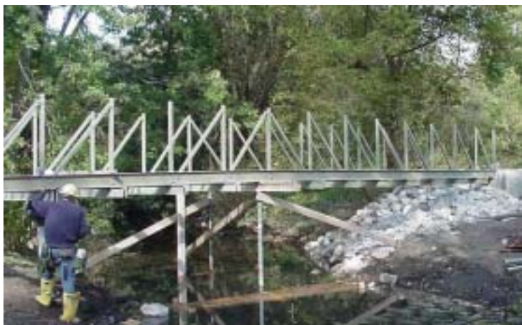
写真 3.14 Carey Avenue Bridge 施工中の状況 (Teodecki 氏提供)
