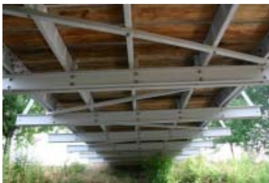
写真 3.9 Middlebury Run Park Bridge の木製床版支持状態
