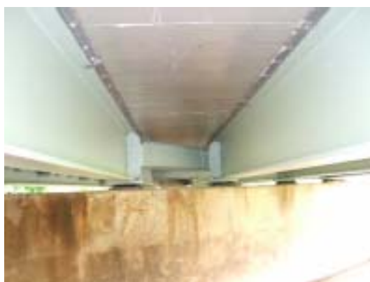
写真 4.12 床版下面（支間部）
