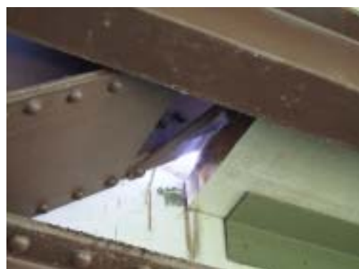
写真 4.18 車道と歩道の床版接続部
