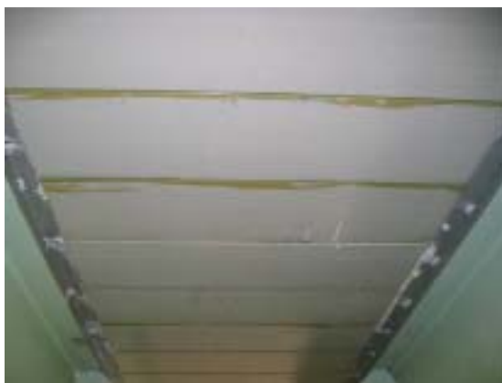
写真 3.7 Dunning Creek Bridge の FRP 床版
