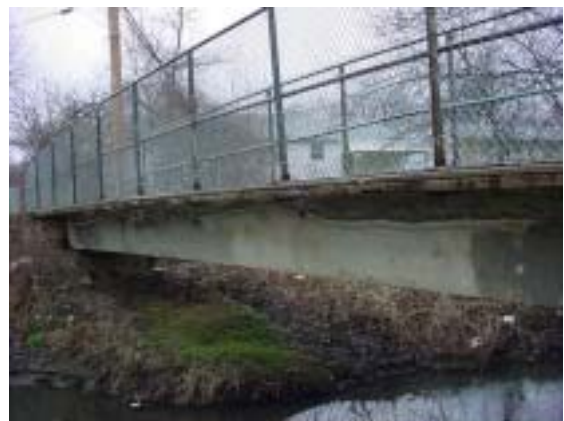
写真 3.13 更新前の Carey Avenue Bridge (Teodecki 氏提供)
