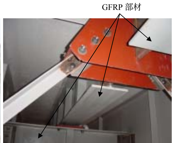
写真 1.2 GFRP 部材の設置状況
