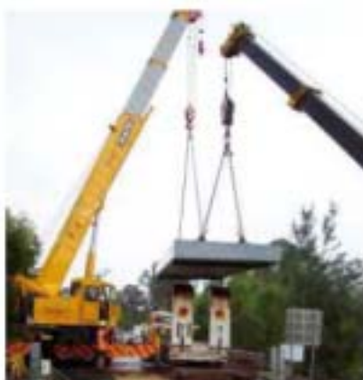
(a) 架設状況
