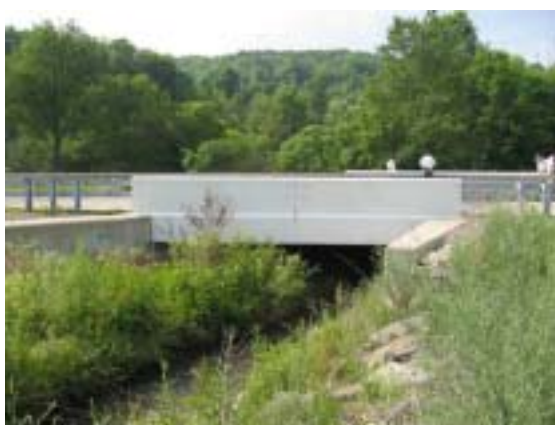
写真 3.18 Bennetts Creek Bridge 全景
