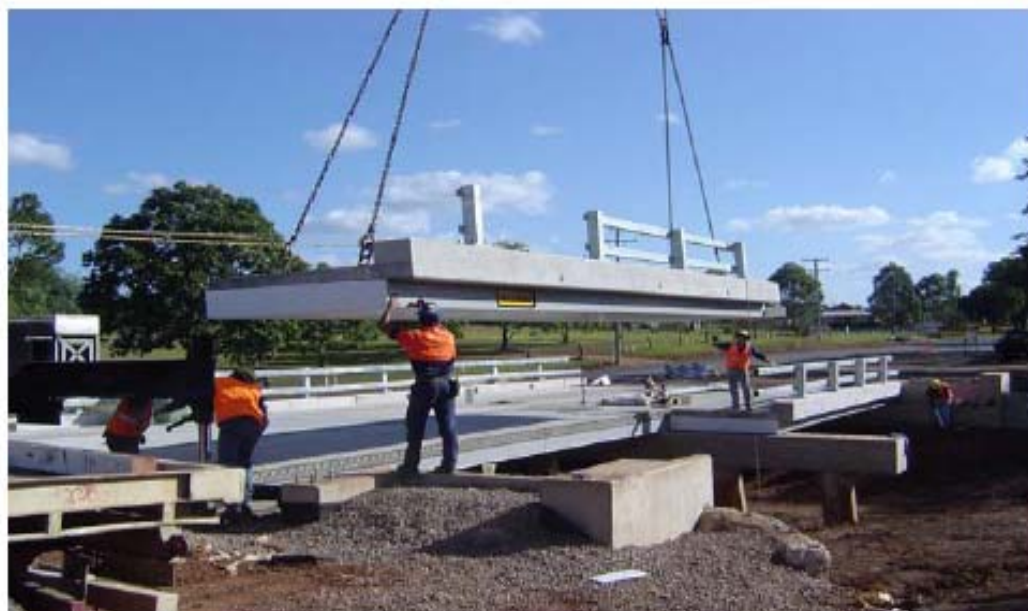
図 4.10 Taromeo CK 橋の架設状況
