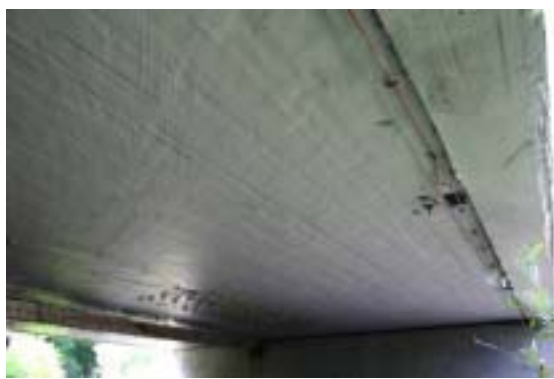
写真 3.19 Bennetts Creek Bridge の FRP 床版
