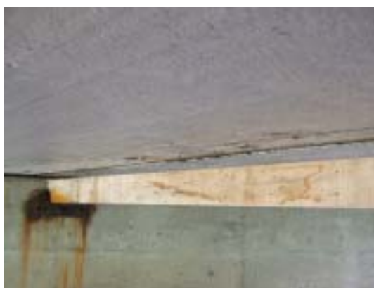
写真 4.22 底面（橋軸方向継手部）
