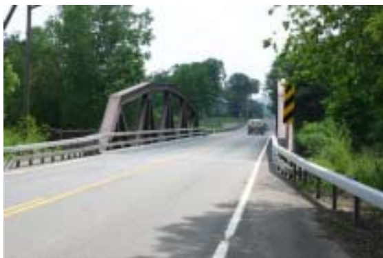
写真 3.16 Bently Creek Bridge の全景
