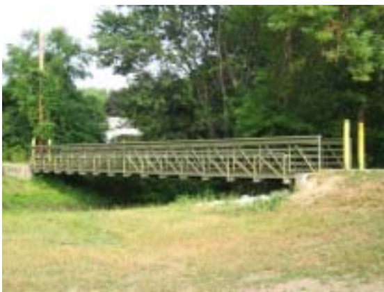
写真 3.12 Carey Avenue Bridge 全景
