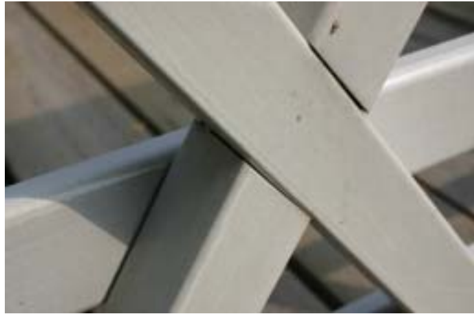
写真 3.11 斜材交差部分
