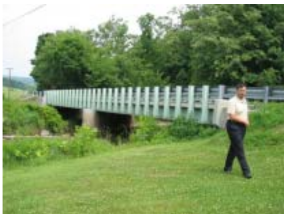
写真 3.6 Dunning Creek Bridge 全景
