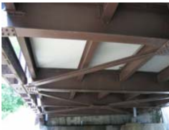
写真 3.17 Bently Creek Bridge の FRP 床版
