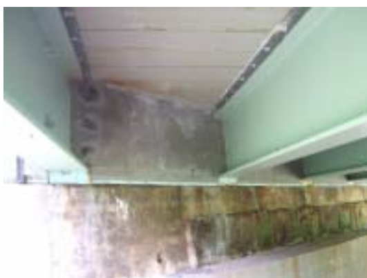
写真 4.11 床版下面（桁端部）
