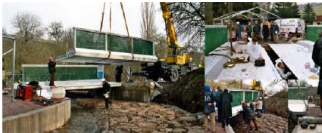
写真 4.25 現場施工状況
