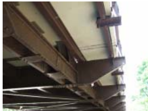
写真 4.16 床版下面（張出部、歩道）
