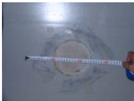
写真 4.2 点検用開口部
