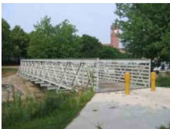
写真 3.8 Middlebury Run Park Bridge 全景
