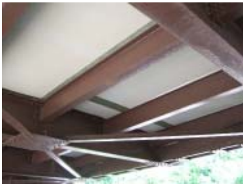
写真 4.15 床版下面（中間部）
