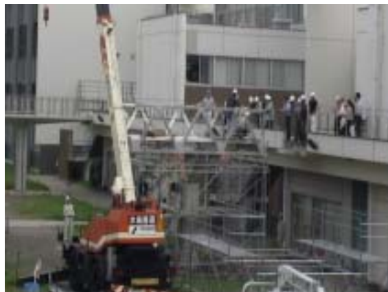
現場架設テスト状況
