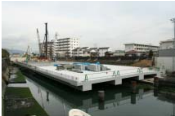
写真 1.3 FRP 合成床版の全景
