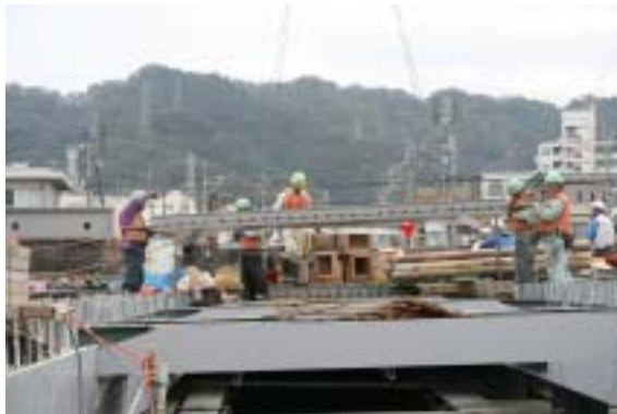
写真 1.4 FRP 合成床版の架設状況
