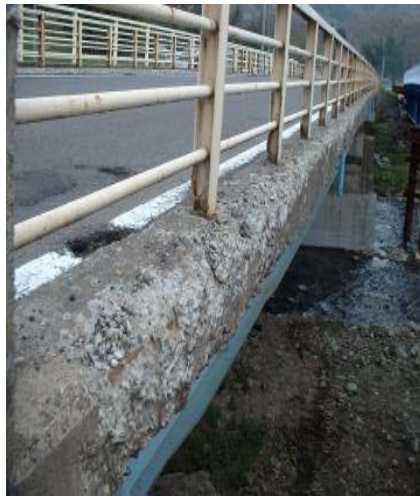
写真 4.3 工事前の状況
