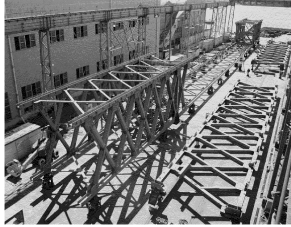
写真-解 9.2.2 トラスの分割仮組立例
