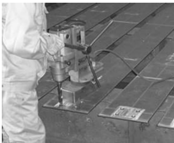
写真-解 3.5.3 簡易式電動ドリルによる孔明け
