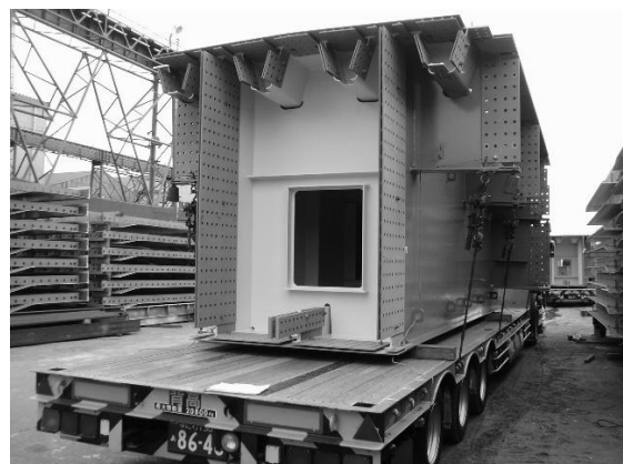
写真-解 8.2.2 塗装桁の輸送
