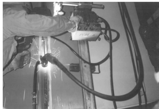
写真-解 5.6.4 立向き自動溶接の施工状況
