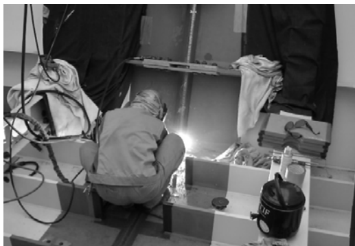
写真-解 5.6.3 下向き半自動溶接の施工状況
