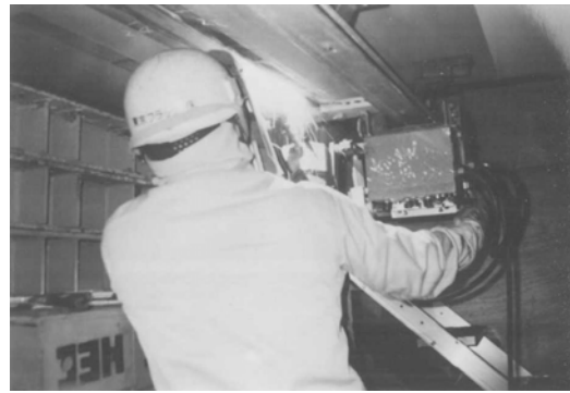
写真-解 5.6.2 上向き自動溶接の施工状況
