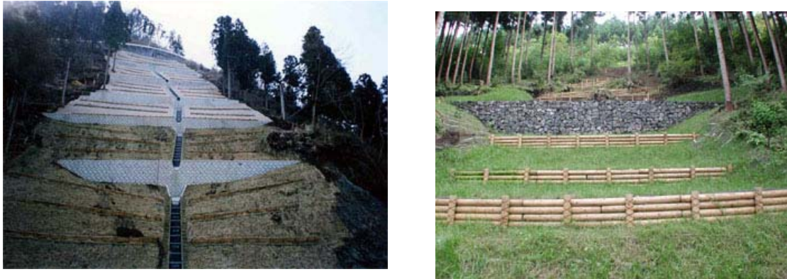
図-4.3.28 山腹工施工例
