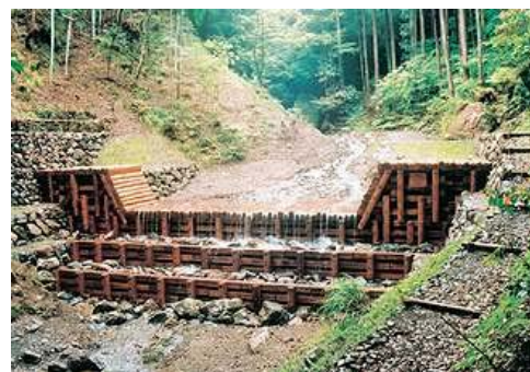
図-4.3.27 床固工施工例
