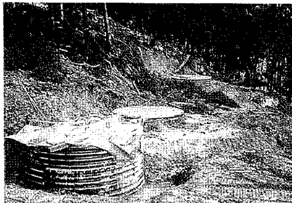
写-4.2.6 鋼管杭、深礎杭の施工
