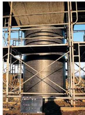
写-4.1.13 炭素繊維設置完了 9)
