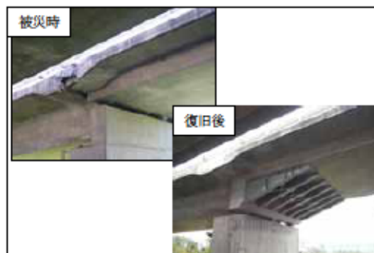
写-4.1.19 上部工桁の連結 8)
