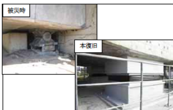
写-4.1.18 鋼製支承からゴム支承への変更 8)
