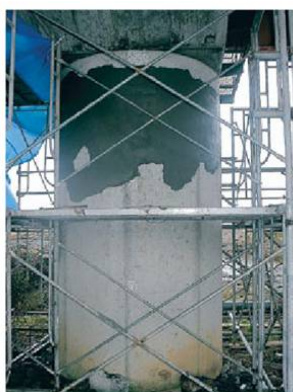
写-4.1.12 モルタルによる断面修復
