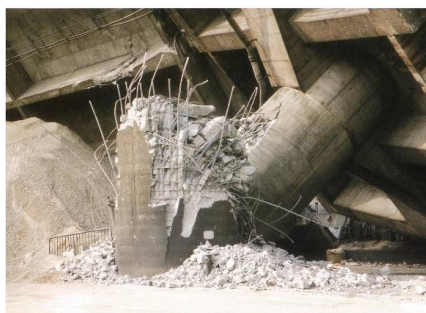
写-4.1.1 阪神高速3号神戸線ピルツ高架橋の倒壊(提供:読売新聞)
