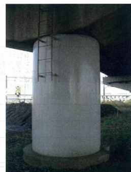
写-4.1.14 上り線鋼板巻き立て補強 10)
