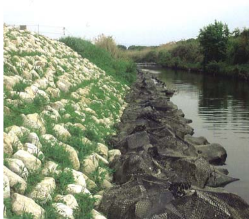
図-4.13 がんぐりまっと（前田工織）【適応流速 5m/s】
