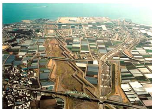
図-4.3.30 導流堤施工例
