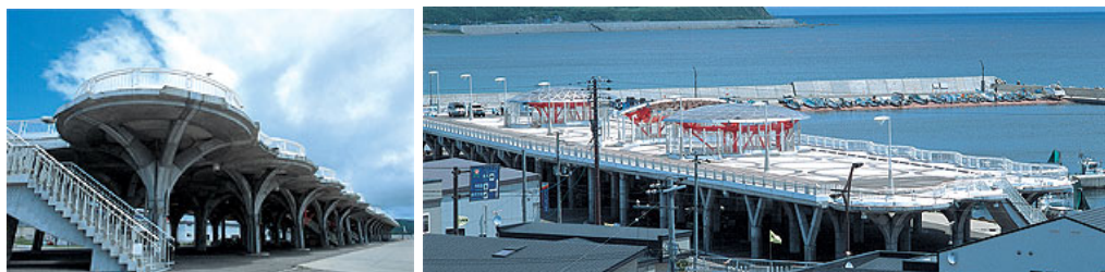
図-4.6.15 奥尻島青苗漁港人工地盤
