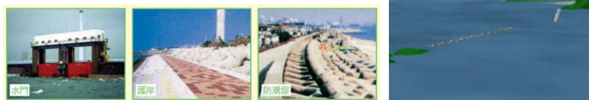
図-4.6.6 ハードによる防災（水門，護岸，防潮堤，湾口防波堤）
