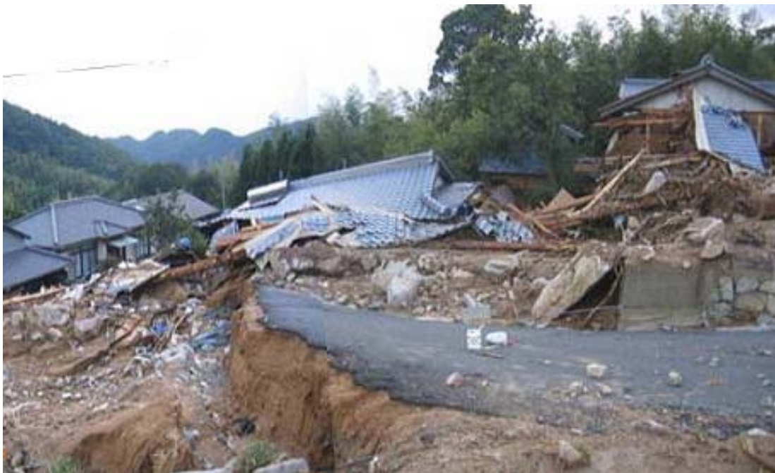
図-4.3.3 平成 16 年 10 月 台風 23 号による土砂災害状況
