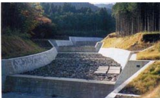
図-4.3.27 床固工施工例
