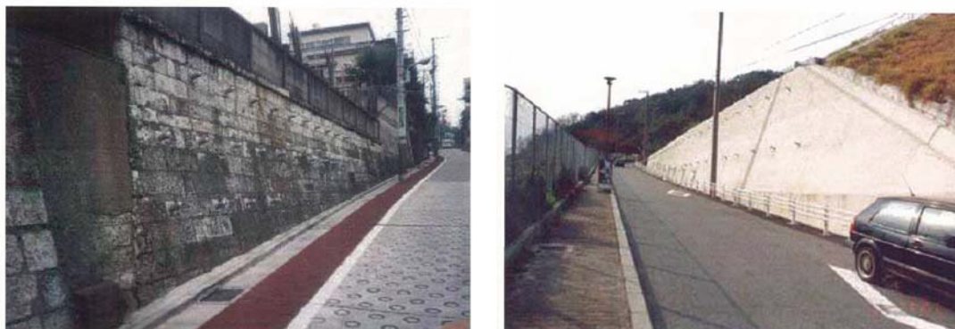
写－4. 2. 12 石積擁壁の耐震補強事例
