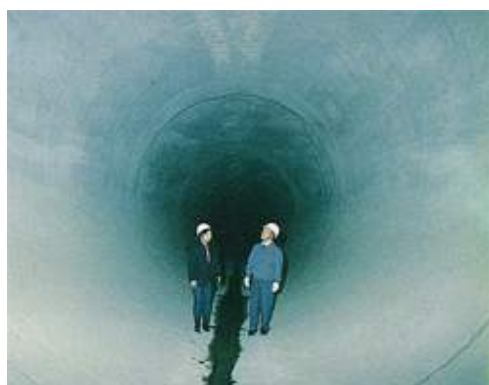
管きょの整備(野川第二幹線 三鷹市)
