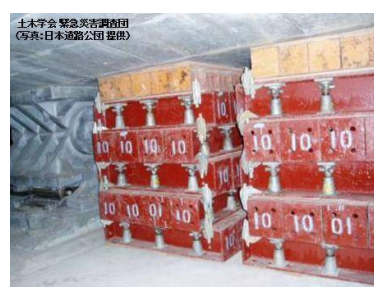
写-4.1.17 P2 橋脚支承部の応急復旧措置 11)
