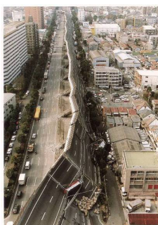
写-4.1.1 阪神高速3号神戸線ピルツ高架橋の倒壊(提供:読売新聞)
