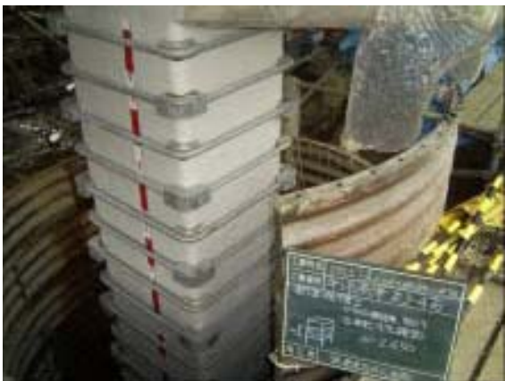
RB 補強状況
