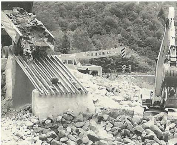
写真-1 粒径処理 (二次処理)
