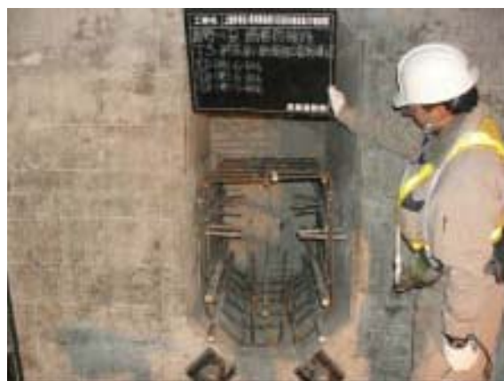
開口部内補強筋配置状況
