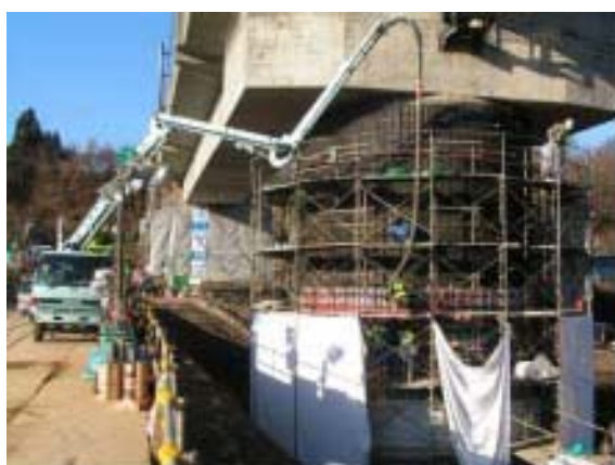
コンクリート打設状況
