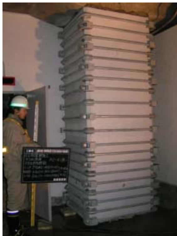
RB 補強完了（柱全景）
