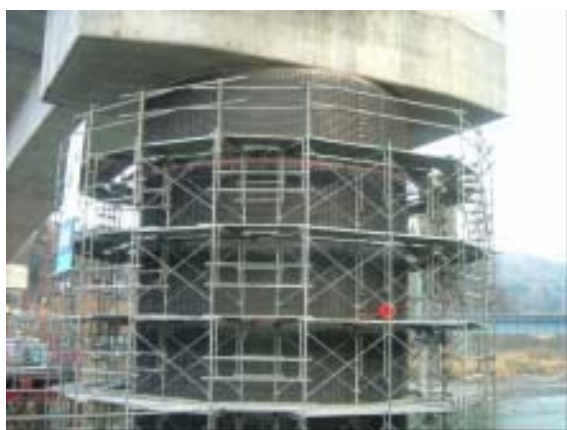
RC 巻立て鉄筋組立状況
