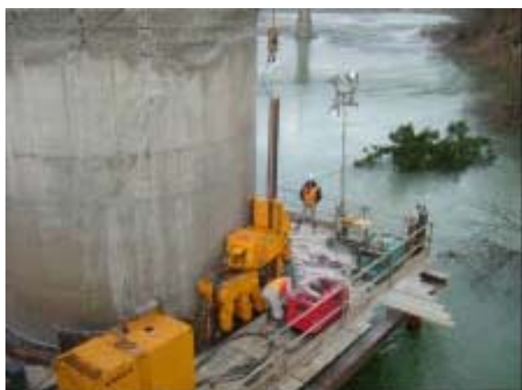
2P JES 鋼矢板打設状況
