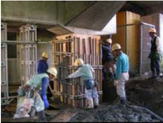
型枠組立状況
