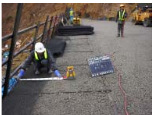
補強土工(盛り立て)
