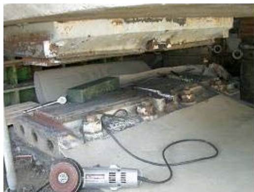
ローラー及び交換部材撤去状況
