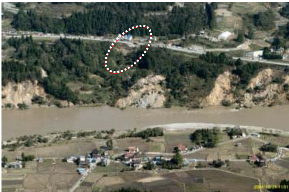
図-2 崩壊箇所遠景
