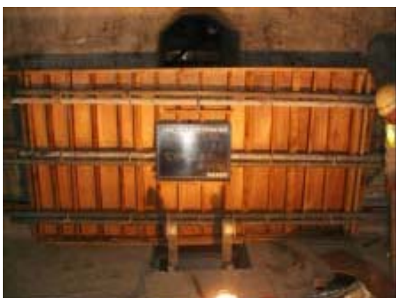
2ロット目型枠組立完了
