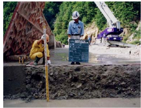
写真④-3 出来形検測
