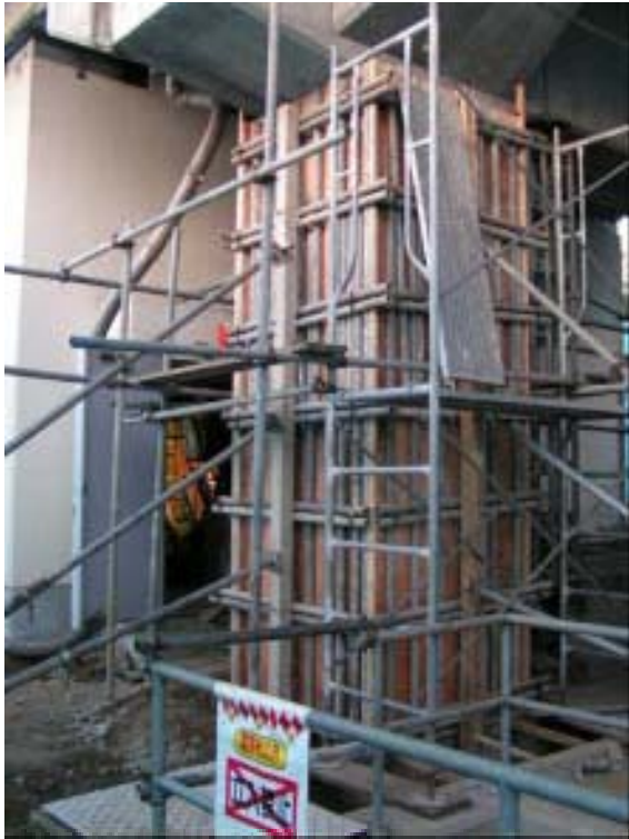
型枠組立完了
