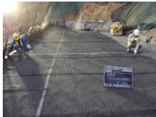
補強土工(補強材敷設)
