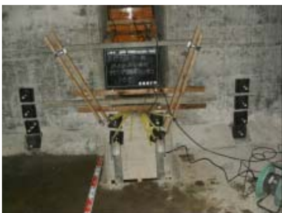
ゲビンデ鋼棒配置状況
