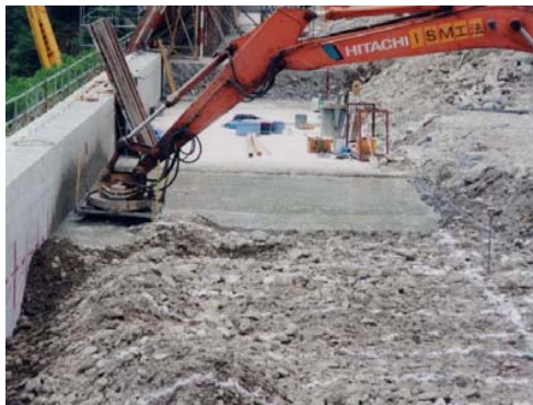
写真④-2 搅拌混合状况
