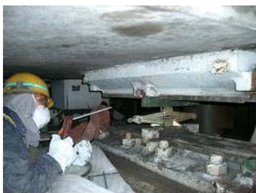
センターブロック取付状況
