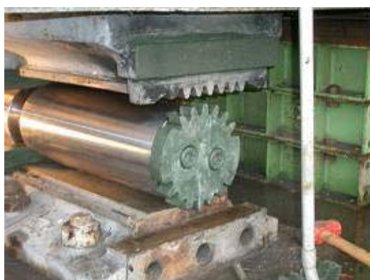
新規ローラー設置状況
