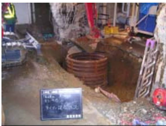
ライナー建込み、掘削状況
