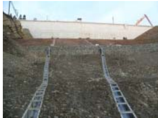
のり面排水工
