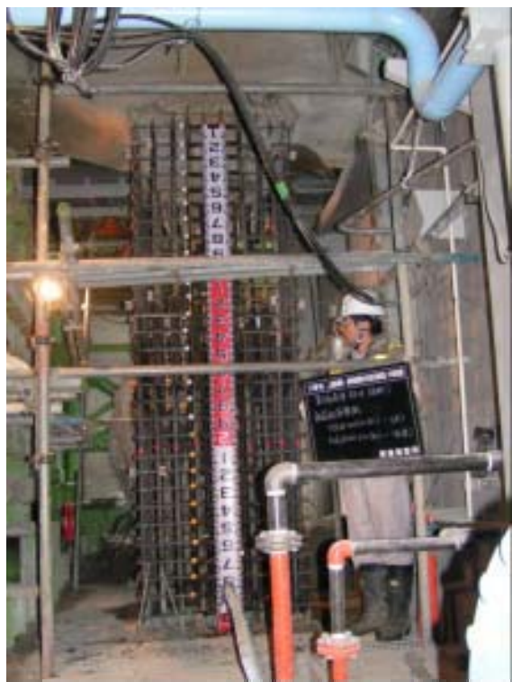
鉄筋組立完了
