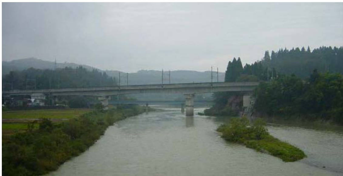
図-3 魚野川橋梁全景
