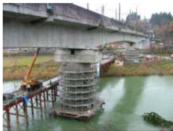
2P 施工状況 (全景)
