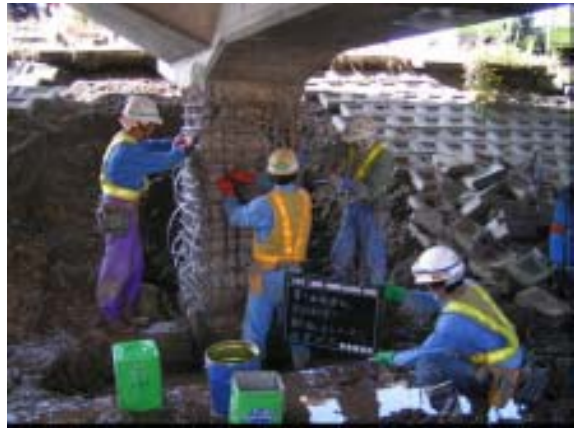
断面修復状況
