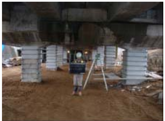
補修完了全景
