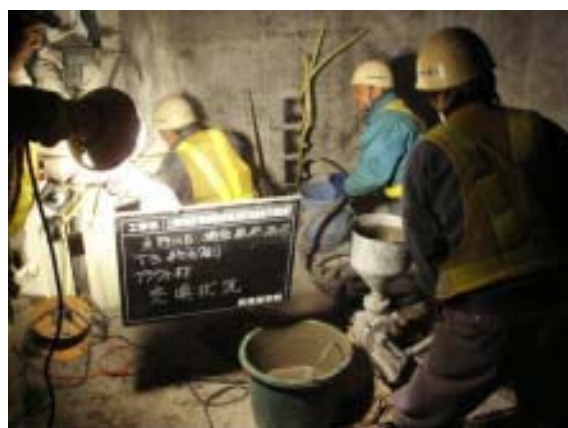
グラウト状況
