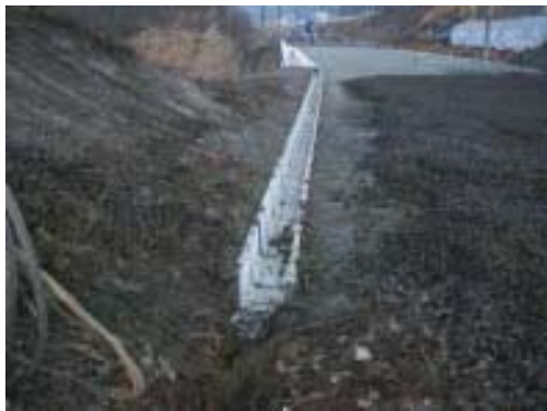
施工基面上排水工
