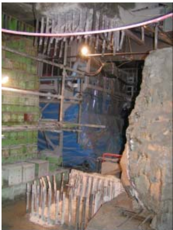
柱切断、コンクリートはつり完了
