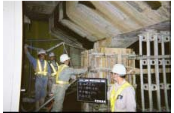
無収縮モルタル打設状況
