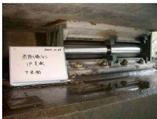
支承補修完了
