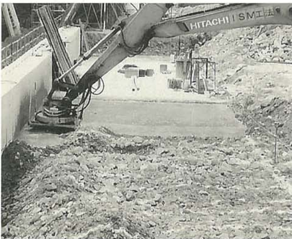
写真-2 攪拌混合状況
