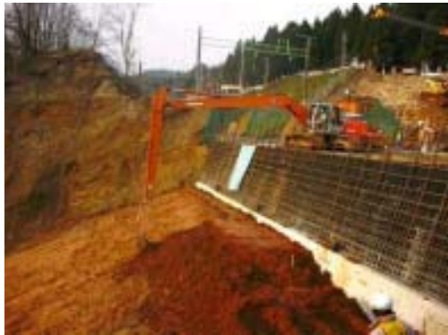
補強土工前面のり面整形
