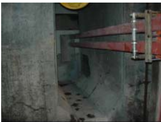
損傷部はつり状況
