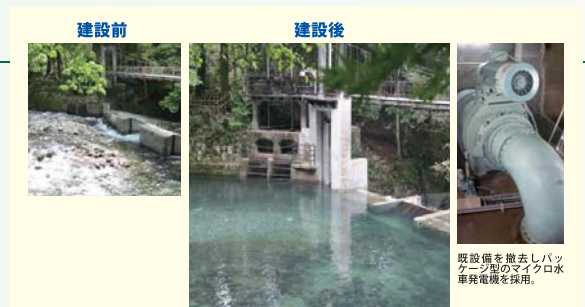
取水堰堤切欠き部にSR合成堰を設置・魚道整備により、魚類の遡上も確認される美しい水面が復活。
