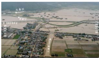
H2.7洪水 R34の冠水状況
