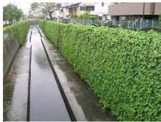
ツタによる護岸の緑化
