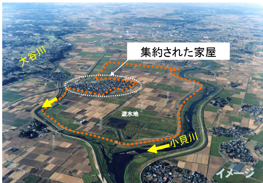
母子島遊水地の状況(平成2年度完成)
