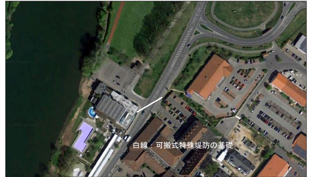
図-12 道路を横切り設置された可搬式特殊堤防の基礎
