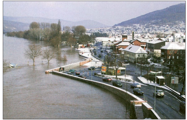
図-18 2003年の20年確率洪水時に設置された 可搬式特殊堤防 (文献1より引用)
