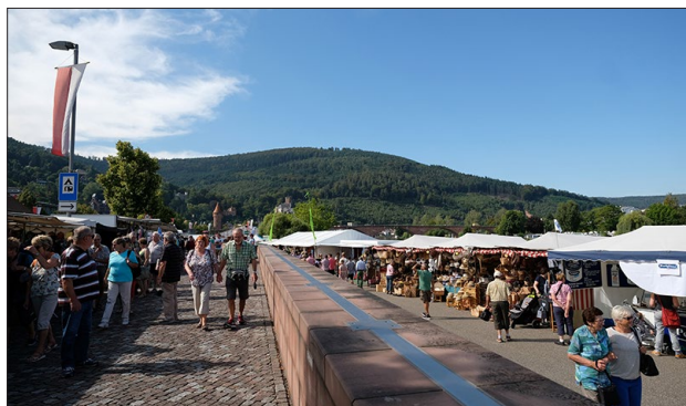
図-8 25年の確率年数に対応した永久構造の堤防 堤防天端に可搬式特殊堤防の基礎が埋め込まれている
