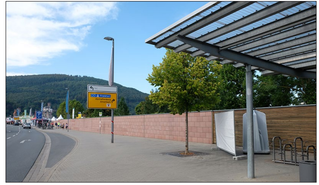
図-11 100年の確率年数に対応した永久構造の堤防
