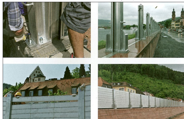
図-16 可搬式特殊堤防の組み立ての様子
