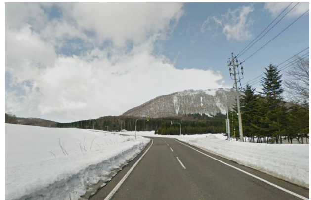
写真-6 事業者による送電線と配電線の地中化事例
