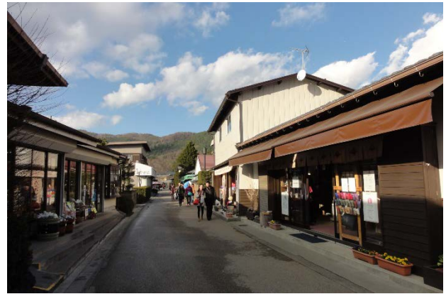
写真-5 地区全体の景観形成の中で行われた電柱移設事例
