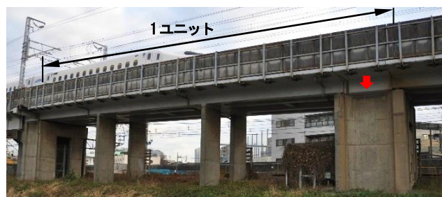
写真-14 目黒川地区高架橋(軟弱地盤のためユニットを短くした)
