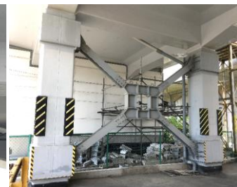
写真-21 X型ブレース補強
