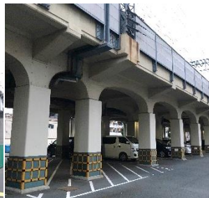
写真-5 近鉄鶴橋高架橋
