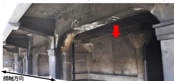
写真-2 阪急梅田高架橋(矢印が橋軸方向の耐震壁)
