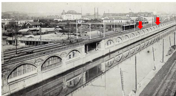
写真-1 新永間市街線高架橋(矢印がグループ橋脚) 1)
