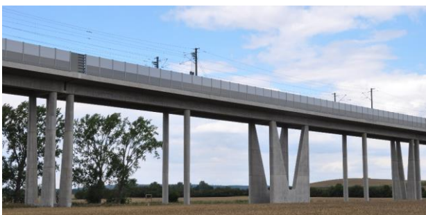
写真-22 ゲンゼバッハ高架橋 (躯体高さ 10m)
