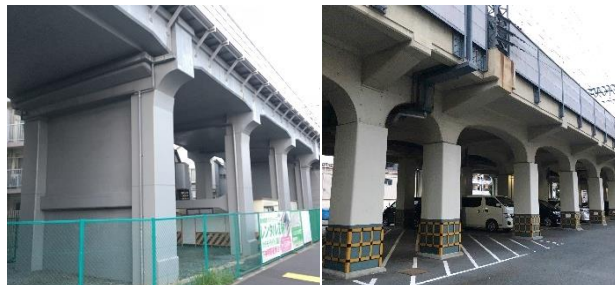
写真-4 東急大井町高架橋
