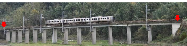
写真-18 篠栗線黒石高架橋
