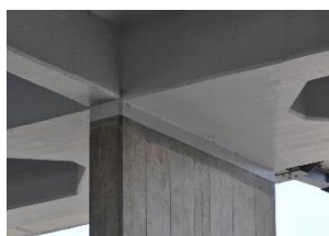
写真-11 梁と柱の接合部
