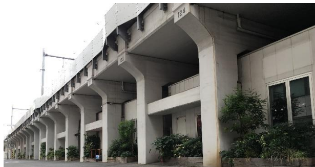
写真-3 上野-神田間 スラブ式高架橋
