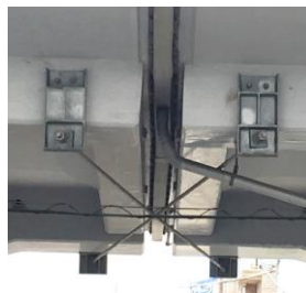
写真-20 目違い防止工
