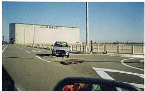
写真3.6.3 マンホール隆起による事故現場
