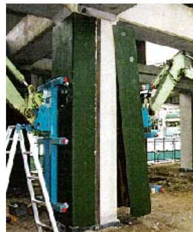
写真 3.3.1 鋼板巻き立て施工事例
