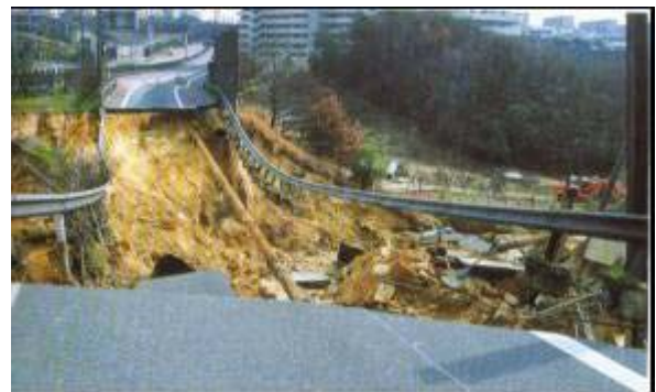
写真3.6.1 大蔵谷I.C.の盛土被害の状況(2) Phot.3.6.1 Damage at Okuradani IC
