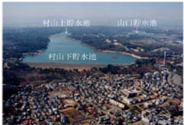
写真 3.9.2 村山ダム(耐震補強工事)の全景 Photograph 3.9.2 Panorama of the Murayama Dam
