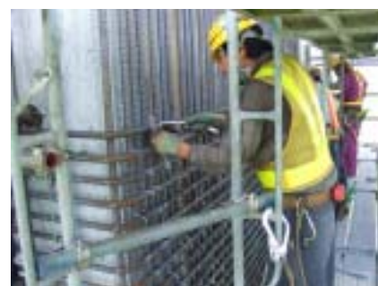
写真 3.3.2 RC を巻き立てる方法の施工事例
