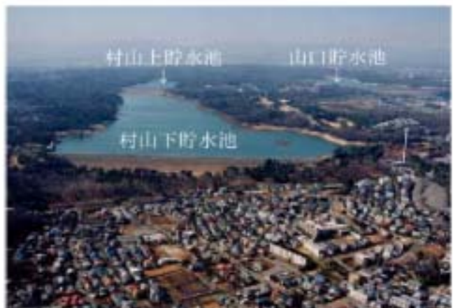
写真 3.9.2 村山ダム(耐震補強工事)の全景 Photograph 3.9.2 Panorama of the Murayama Dam
