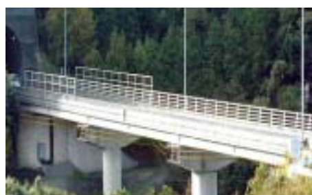
(1)PC 連結材による耐震補強 (国道 202 号 瀬石谷橋)
