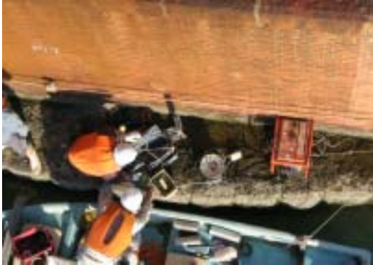
図 3.10.2 コア採取状況 Fig. 3.10.2 Circumstance of sampling
