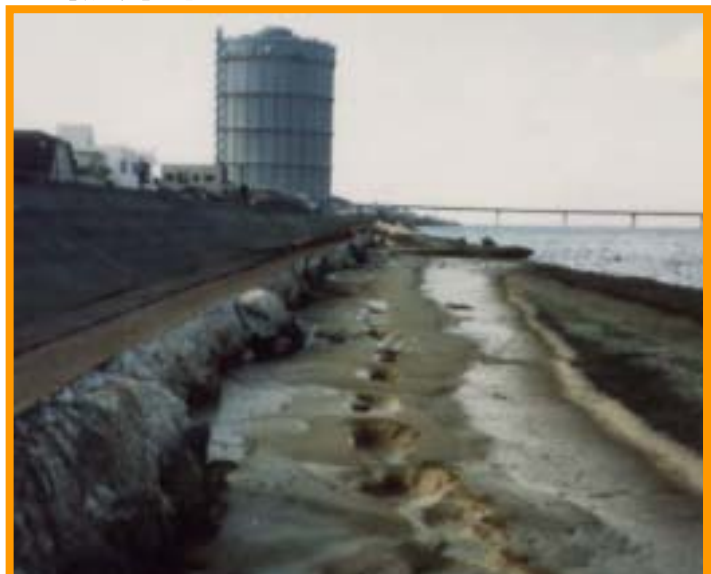
液状化による河川堤防のすべり(淀川)
