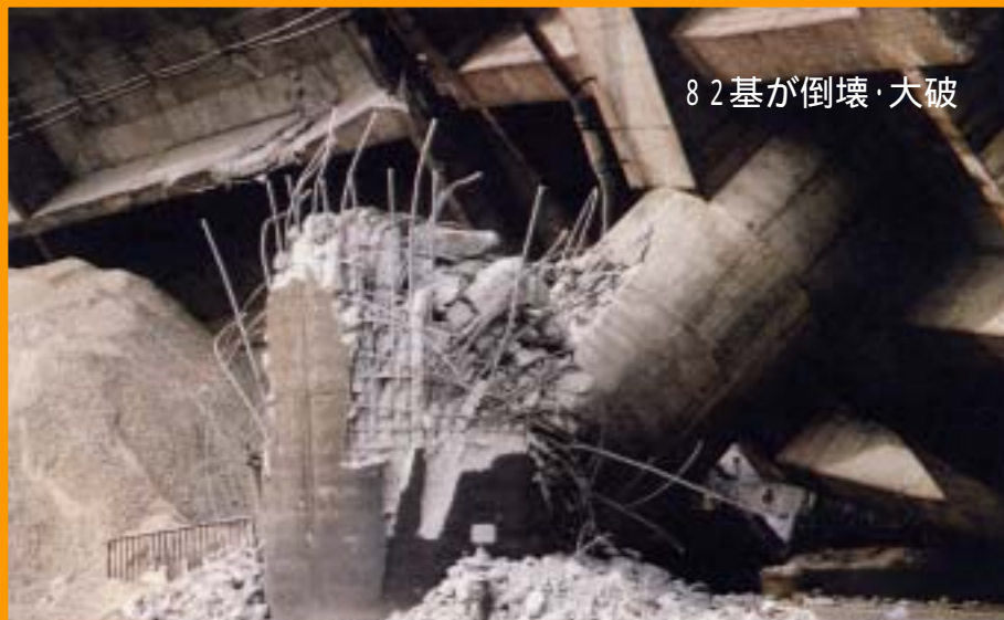
鉄筋コンクリート橋脚のせん断破壊(道路)
