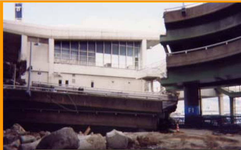
基礎の移動による橋桁の落下(神戸大橋)
