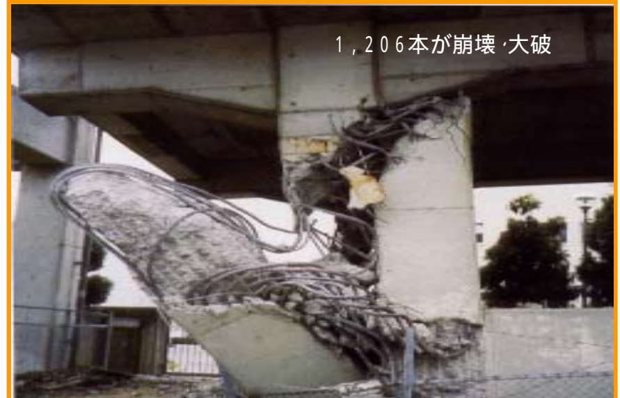
高架橋コンクリート柱のせん断破壊(鉄道)
