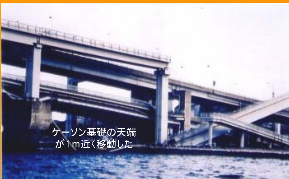
基礎の移動による橋脚の落下(六甲ライナー)
