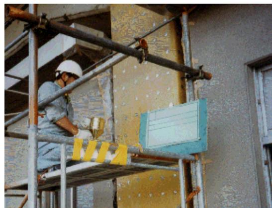
写真4.4.3 FRPシート巻き立て施工例
