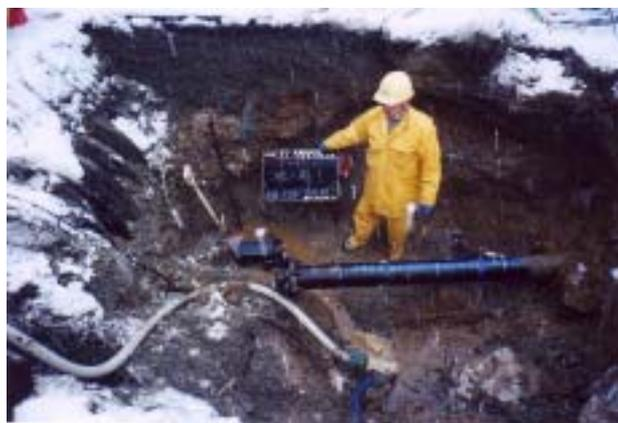
図7.2.20 管路被害状況(DCIP)
