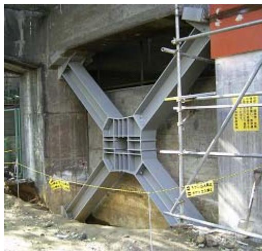
写真 4.4.8 ダンパー・ブレースを用いる方法の施工事例
