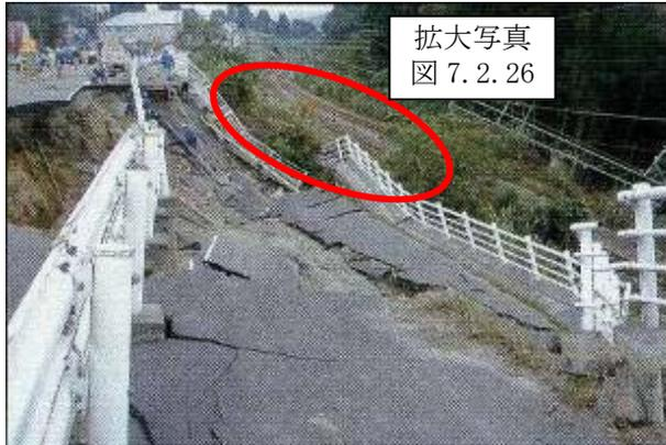
図 7.2.25 斜面崩壊（小千谷市・川口町）<sup>15)</sup>
