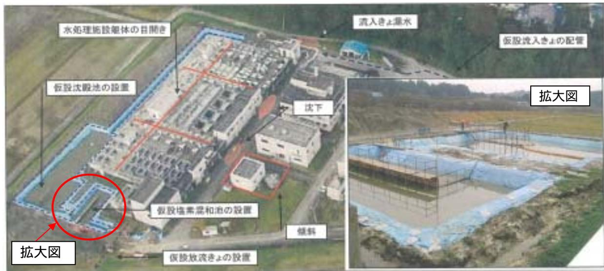
図 7.2.27 堀之内浄化センターの被害箇所と簡易処理施設の配置図<sup>16)</sup>
