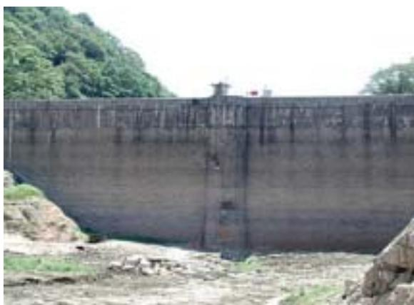
写真 10.14 布引ダムの貯水池内の堆砂状況
