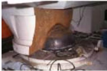
(2)ピボット支承の損傷
