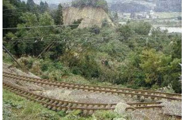
図 7.2.26 斜面崩壊（小千谷市・川口町）<sup>15)</sup>
