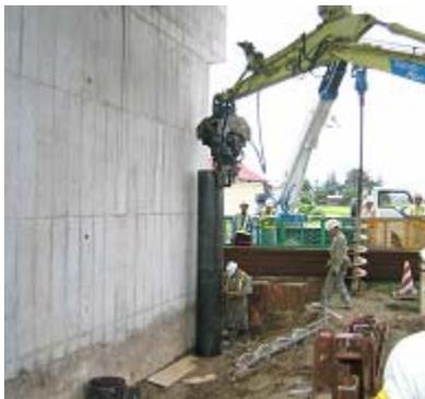
写真 4.4.11 コンクリート充填鋼管を設置する方法の施工事例
