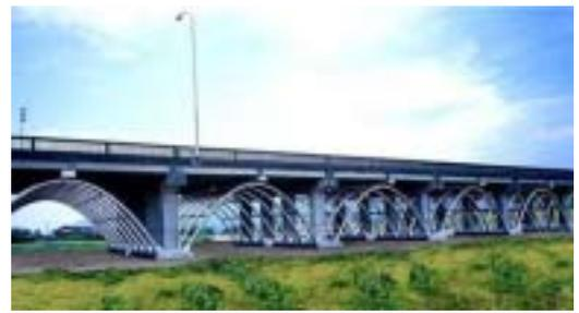
(2)鋼製アーチによる耐震補強
