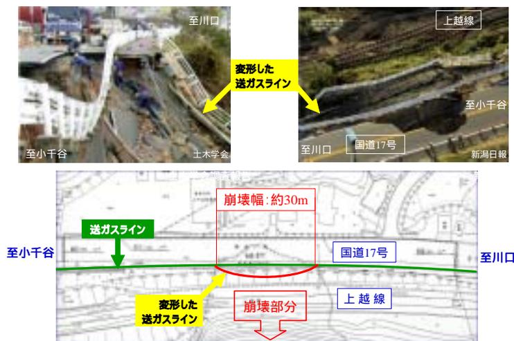
図 7.2.30 道路盛土の崩壊と送ガスラインの変形状況<sup>19)</sup>
