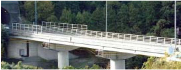
(1)PC 連結材による耐震補強
