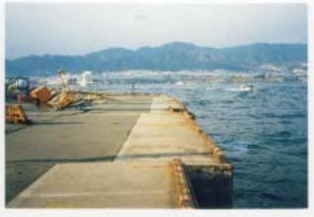
写真 5.2.2 重力式岸壁の被災事例（神戸港・北埠頭・岸壁法線の出入り）
