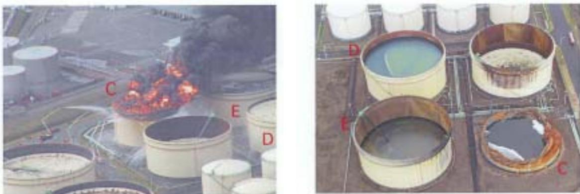
図-8.3.2 苫小牧タンクの火災被害（全面火災を生じ焼失した C タンクと浮屋根が沈没した隣接タンク）[4]
