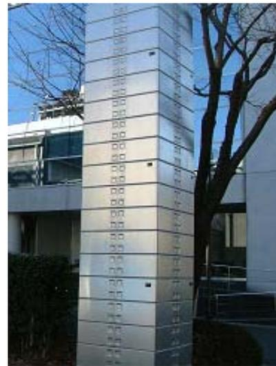
写真4.4.2 鋼製パネル組立て耐震補強の施工試験
