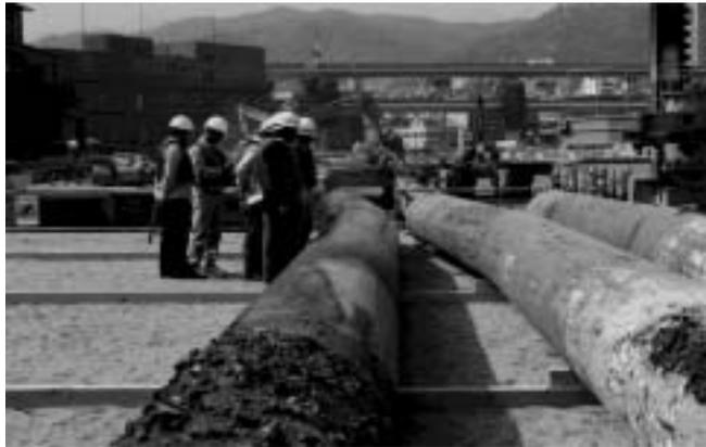
写真5.2.5 被災した桟橋式岸壁の杭<sup>1)</sup>
