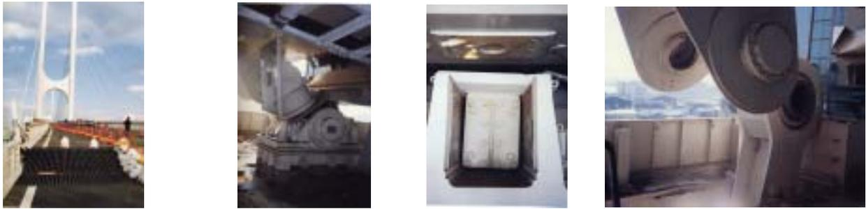
(1)桁の沈下による段差 (2)ベーンダンパーの損傷 (3)ウインド沓の損傷 (4)ペンデル支承の損傷
