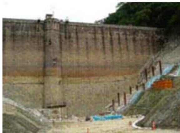
写真 10.15 布引ダムの堆砂除去後の状況
