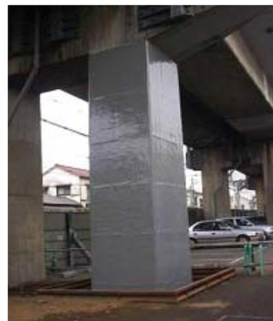
写真 4.4.10 繊維シートを巻き立てる方法の施工事例
