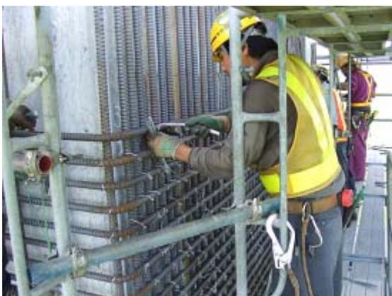
写真 4.4.9 鉄筋コンクリートを巻き立てる方法の施工事例
