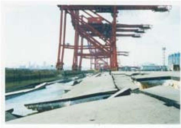
写真5.2.1 重力式岸壁の被災事例（神戸港・六甲アイランドRC-5）
