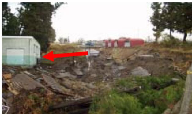
図7.2.18 斜面崩落による上水道施設の被害（小千谷市）
