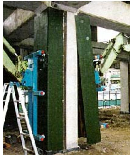
写真4.4.2 鋼板巻き立て施工事例
