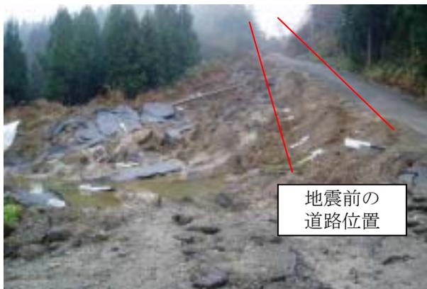
図7.2.17 斜面崩壊（川口町）
