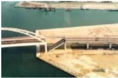
(1)隣接径間部の桁の落下
