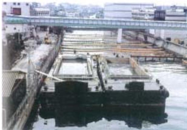
図 7.2.11 東灘処理場仮処理施設の台船を用いた汚泥濃縮槽<sup>12)</sup>
