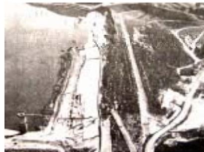
1971年2月9日San Fernando地震(M6.6)の際に地震動によって被害を受けたVan Norman(San Fernando)Dam (アースフィルダム:堤高43m,堤頂長634m,震央距離14km)
