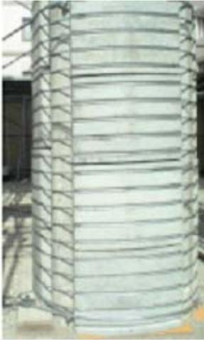
写真 4.4.6 コンクリートセグメントと鋼より線を用いる方法の施工事例
