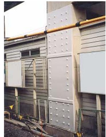
写真 4.4.7 一面から施工する方法の施工事例
