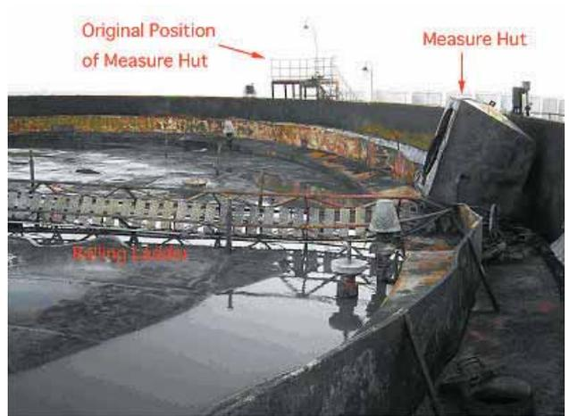
写真-8 地震直後にリング火災が発生した容量約 3 万 m<sup>3</sup> の原油タンクにおける浮き屋根の回転
