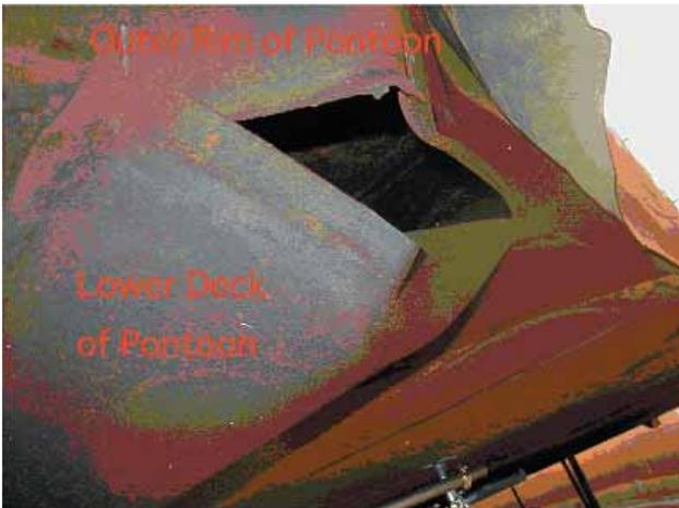
写真-6 破損した浮き屋根浮き室（出光興産（株）撮影）
