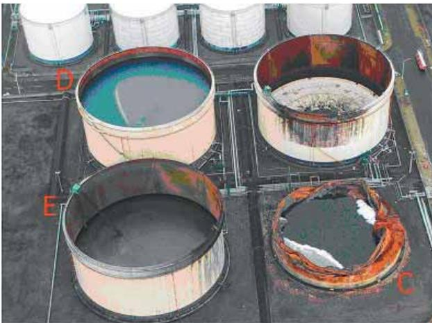
写真-5 浮き屋根が沈没した容量約 4 万 m<sup>3</sup> の灯油タンク（札幌市消防局撮影）
