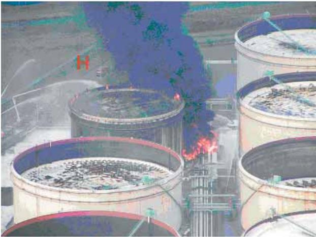
写真-1 地震直後に発生したリング火災と配管からの火災（札幌市消防局撮影）
