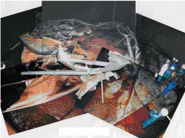
写真-3 石狩市の石油タンクにおける浮き屋根破断（石狩北部地区消防本部撮影）
