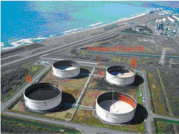
写真-4 浮き屋根が沈没した容量約 11 万 m<sup>3</sup> の原油タンク（札幌市消防局撮影）
