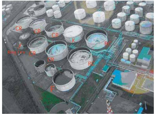
写真-7 浮き屋根が沈没した容量約 4 万 m<sup>3</sup> のスロップタンク（札幌市消防局撮影）
