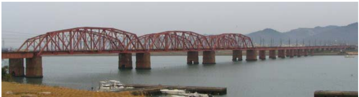
図3.10.1 南海本線紀ノ川橋梁遠景（耐震検討は写真手前の下り線を対象に実施）
