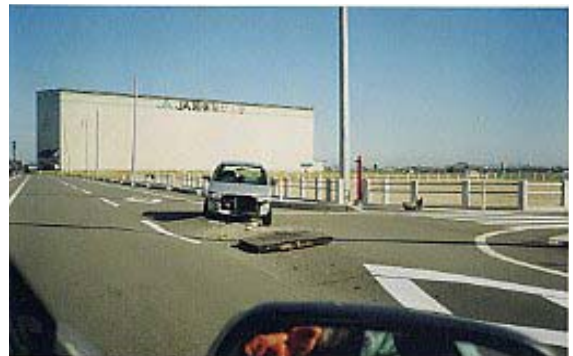
写真3.6.3 マンホール隆起による事故現場 Phot.3.6.3 Accident scene at uplifted manhole
