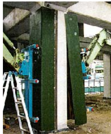
写真 3.3.1 鋼板巻き立て施工事例
