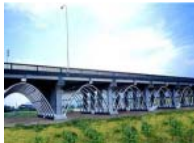
(2)鋼製アーチによる耐震補強 (国道 201 号 東大橋)
