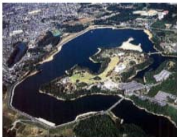
写真 3.9.1 山倉ダム(耐震補強工事)の全景 Photograph 3.9.1 Panorama of the Yamakura Dam
