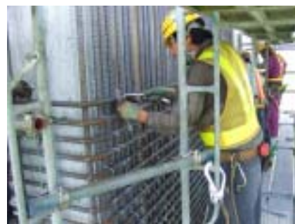
写真 3.3.2 RC を巻き立てる方法の施工事例
