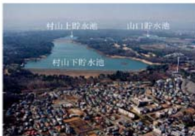
写真 3.9.2 村山ダム(耐震補強工事)の全景 Photograph 3.9.2 Panorama of the Murayama Dam
